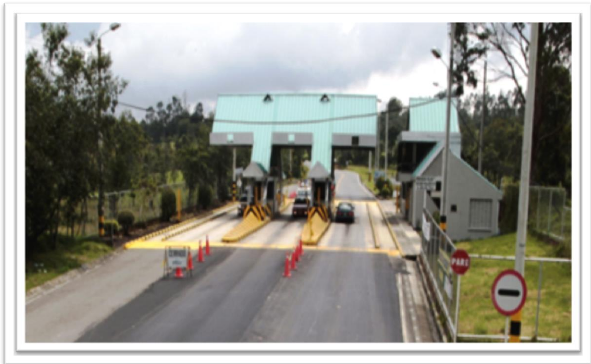
Figura 31. Estación de recaudo de peaje Saboyá. Fuente: Cano Jiménez Estudios S.A.
