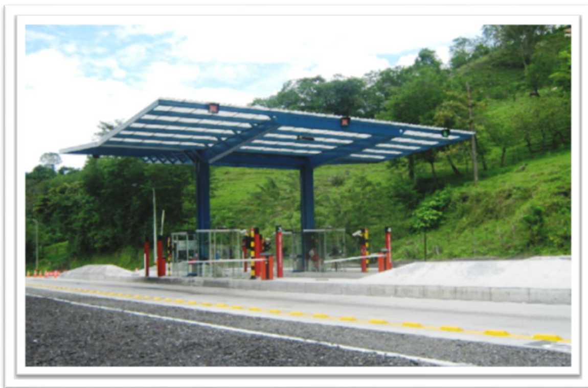
Figura 16. Estación de recaudo de peaje Santágueda. Fuente: www.autopistasdelcafe.com
