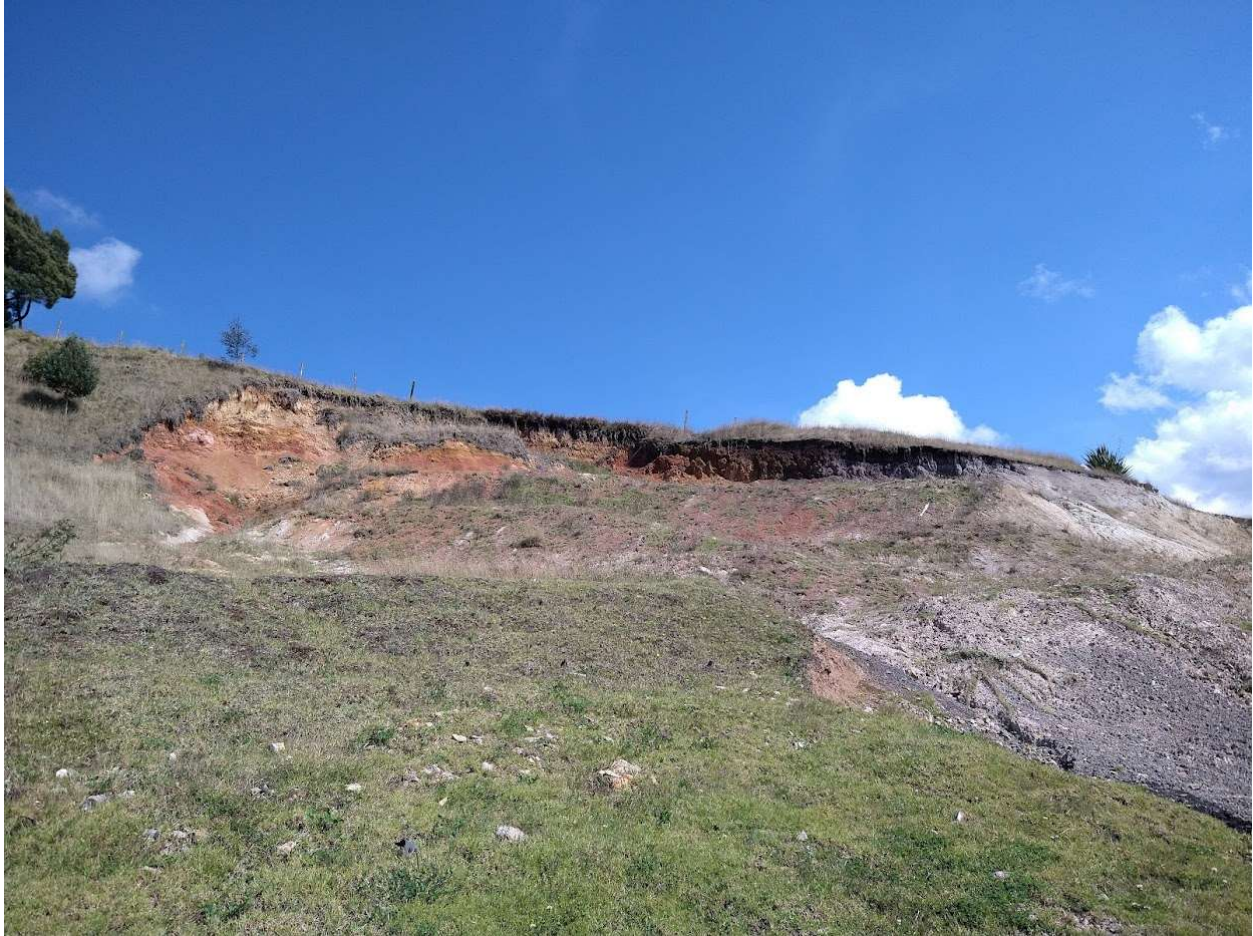
Imagen 1. Deslizamiento en suelos derivados de ceniza volcánica, sector de Tierra Negra, vía Tunja - Sogamoso (Boyacá). Fuente propia.
