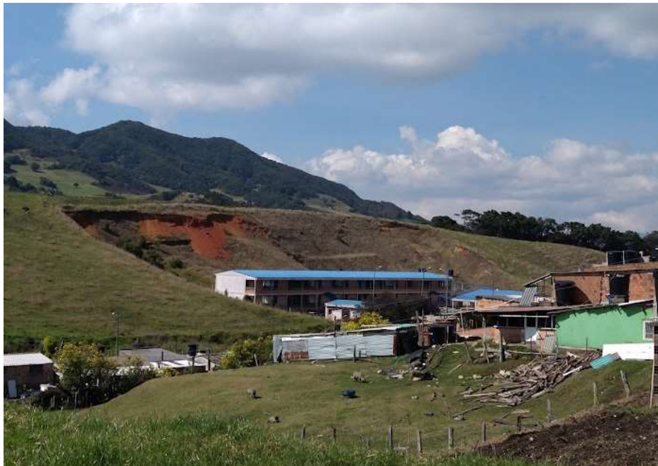
Imagen 23. Enorme deslizamiento cuyo movimiento más probable corresponde a un deslizamiento rotacional, su magnitud se aprecia en la figura 26 de la sección 4.3. Evidencia las grandes masas que involucra este tipo de depósitos. Fuente propia.
