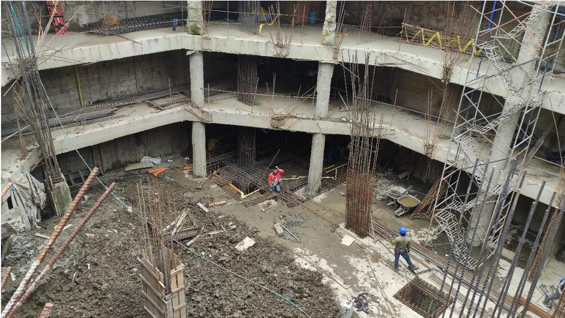
ILUSTRACIÓN 17 PROCESO DE PLACA FLOTANTE TOBERIN 3A
