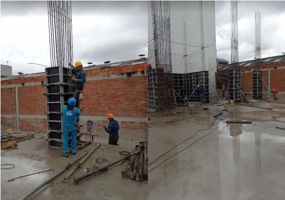
ILUSTRACIÓN 25 PROCESO DE COLUMNAS Y PANTALLAS TOBERIN 1A
