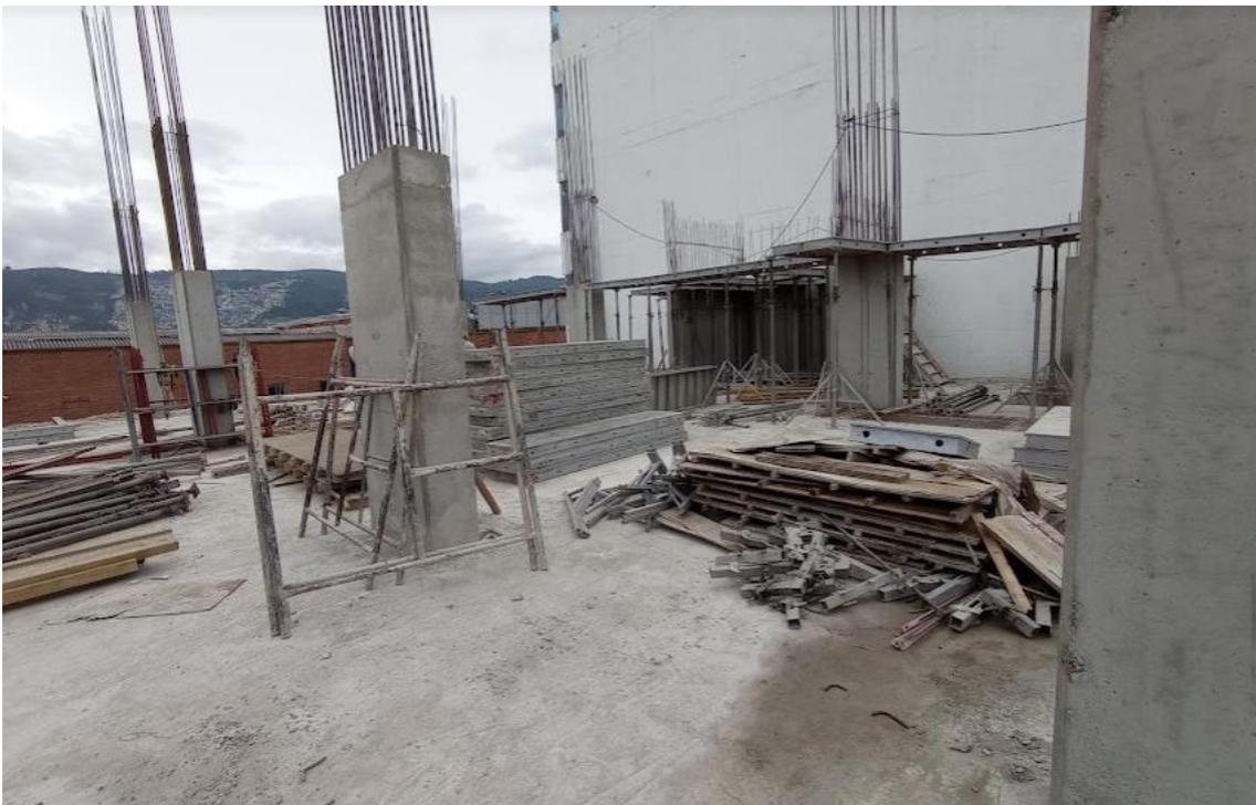
*ILUSTRACIÓN 28 PROCESO COLUMNAS Y PANTALLAS TOBERIN 2B*
