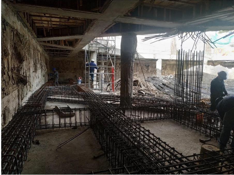
*ILUSTRACIÓN 13 PROCESO VIGA CINTURÓN SÓTANO 1 1B*
