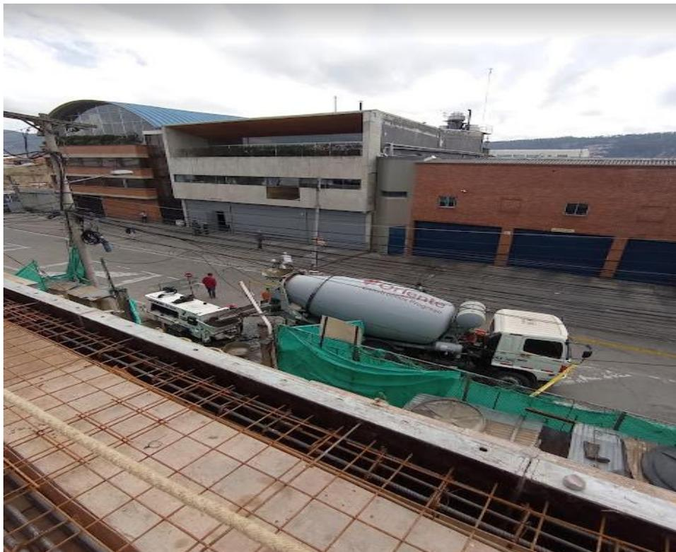
ILUSTRACIÓN 24 PROCESO PLACA ALIGERADA 2B
