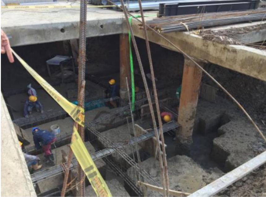
ILUSTRACIÓN 31 PROCESO DE DADOS Y VIGAS STEEL 22
