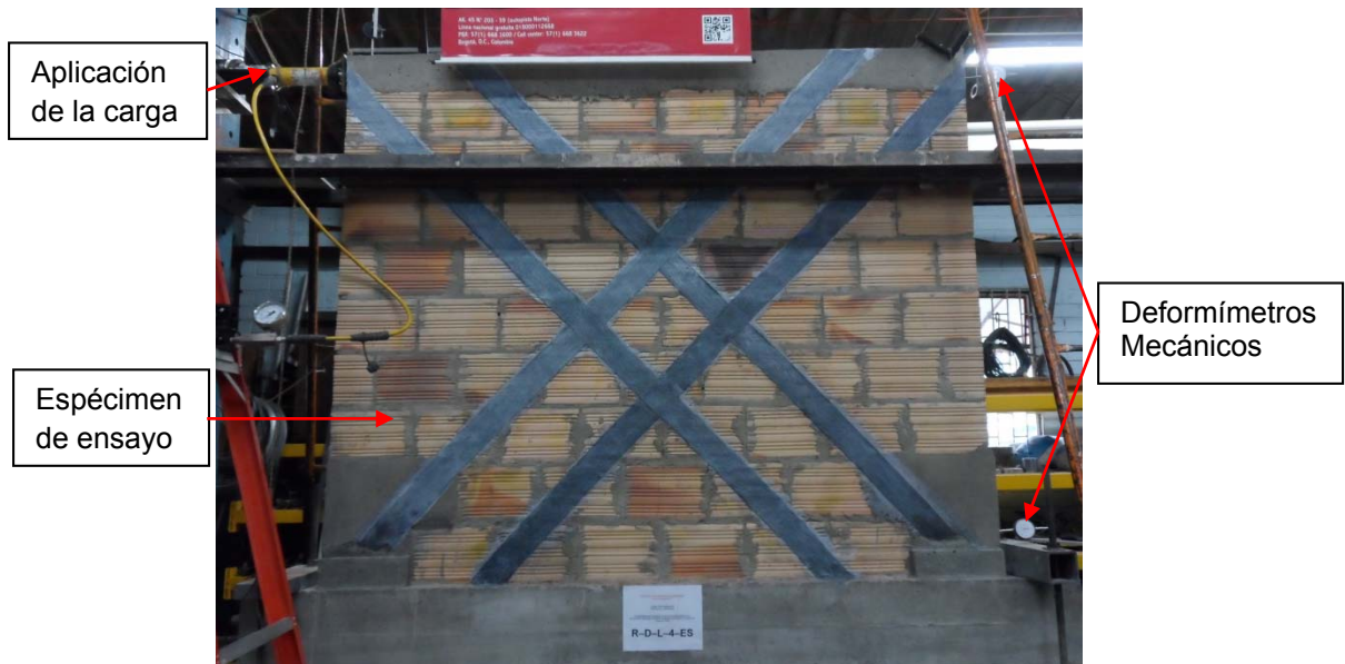
Figura 4-30 Montaje del ensayo monotónico. Fuente: El autor.
