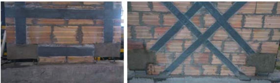
6) Eliminar el poliestireno de la parte inferior de los macizos y limpiar la superficie de cualquier residuo de poliestireno que pueda afectar la adherencia con la segunda etapa de concreto.
