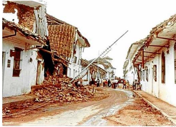
Figura 2-4 Colapso de muros (Terremoto de Popayán, 1983)
