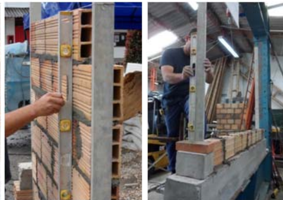
4) Verificación de la verticalidad del muro con la ayuda de un nivel de burbuja.
