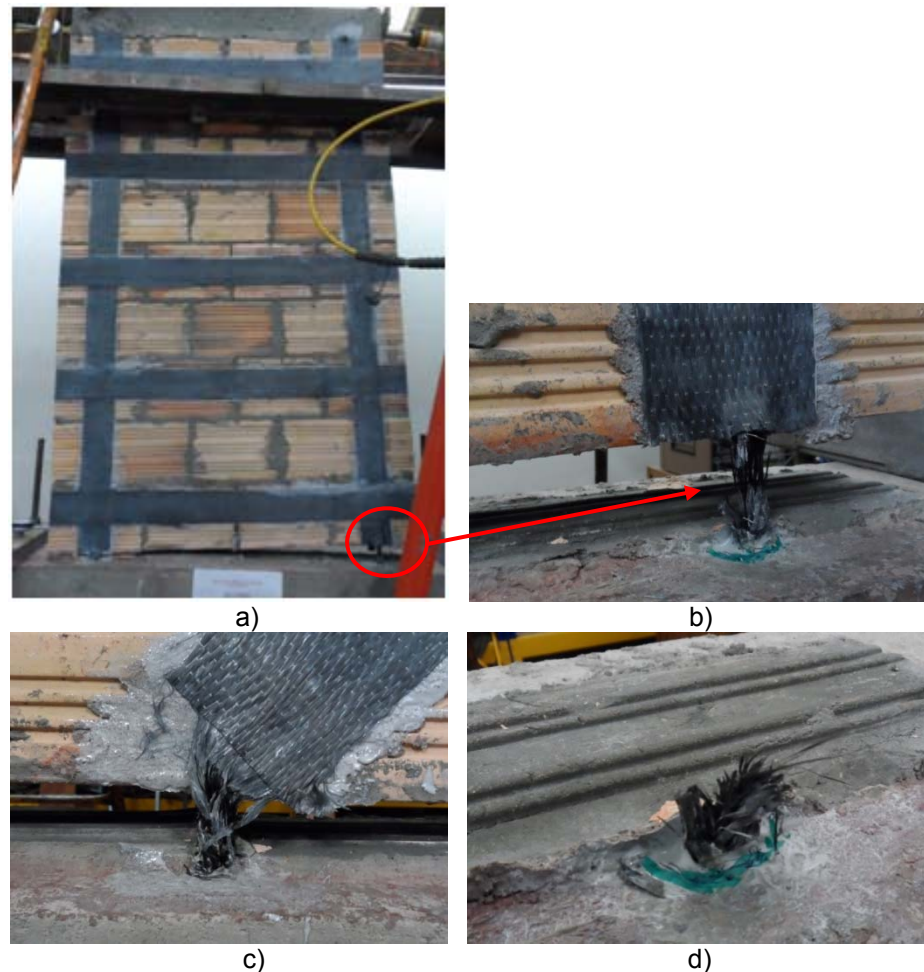
Figura 5-9 Falla del sistema de anclaje No. 1.
