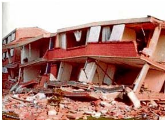
Figura 2-3 Colapso de una edificación residencial (Terremoto de Popayán, 1983)
