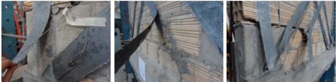
Detalle del arrancamiento (Pull off) de la fibra
