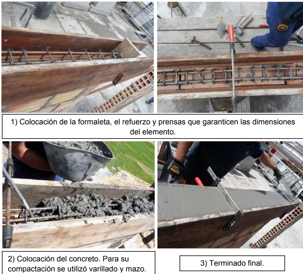
Figura 4-12 Proceso constructivo de las vigas de borde superior.
