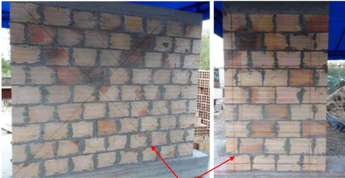
1) Cimbrar en los muros la ubicación de los tejidos
