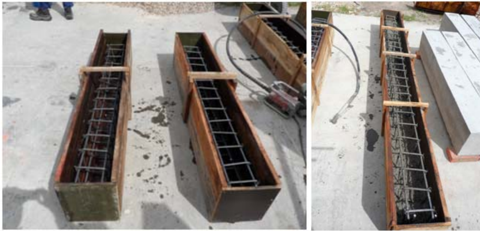
1) Ubicación del refuerzo dentro de la formaleta.
