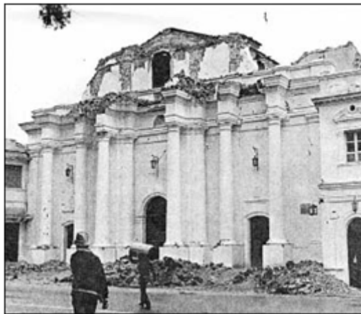
Figura 2-2 Daños en la Catedral Metropolitana (Terremoto de Popayán, 1983)
