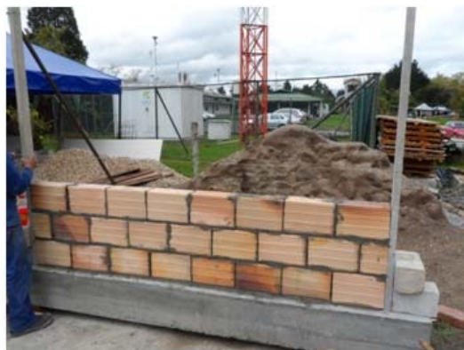
5) Traba adecuada en los muros, evitando aparejo petaca.
