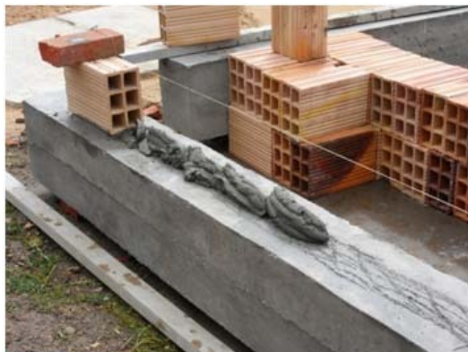
3) Colocación de la primera capa de mortero de pega seguida de la primera hilada de ladrillos.
