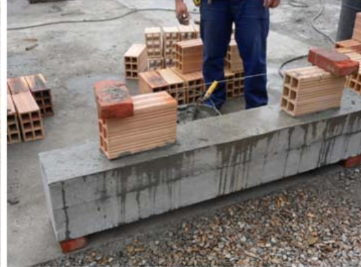
2) Ladrillos guías en las esquinas del muro.
