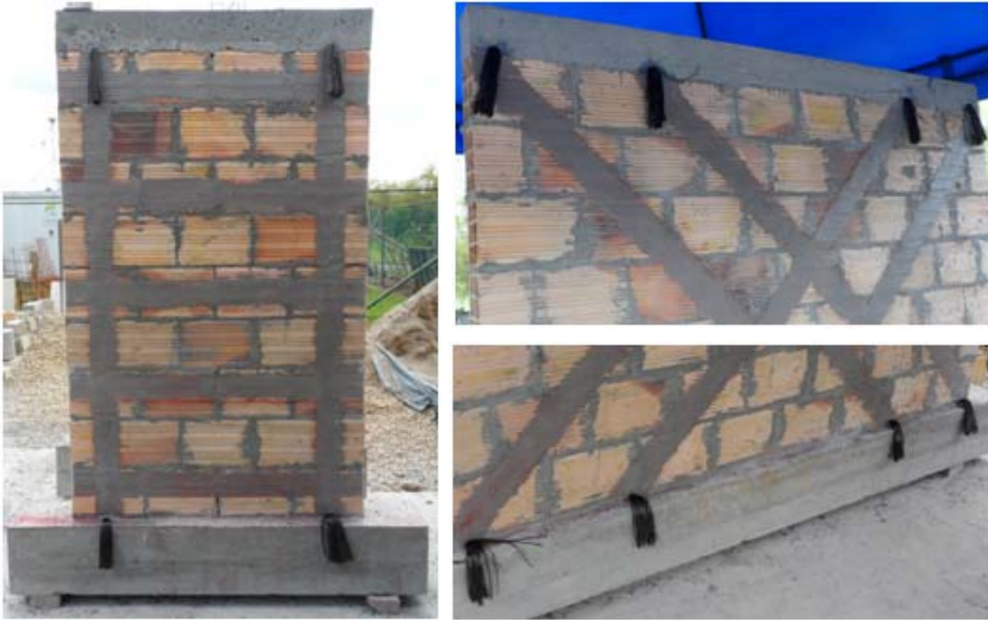
Estado de los corbatines después de anclados
