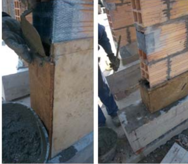
5) Fundir el concreto de la primera etapa
