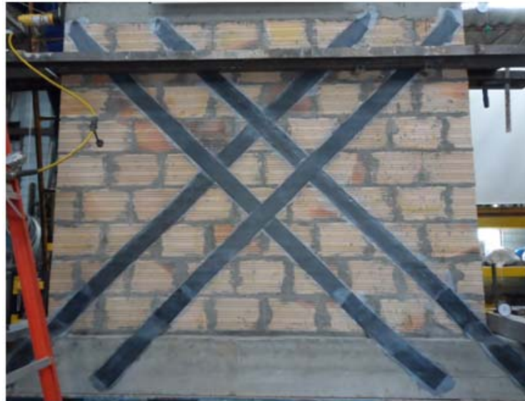
Estado final del muro con el sistema de anclaje No. 2.
