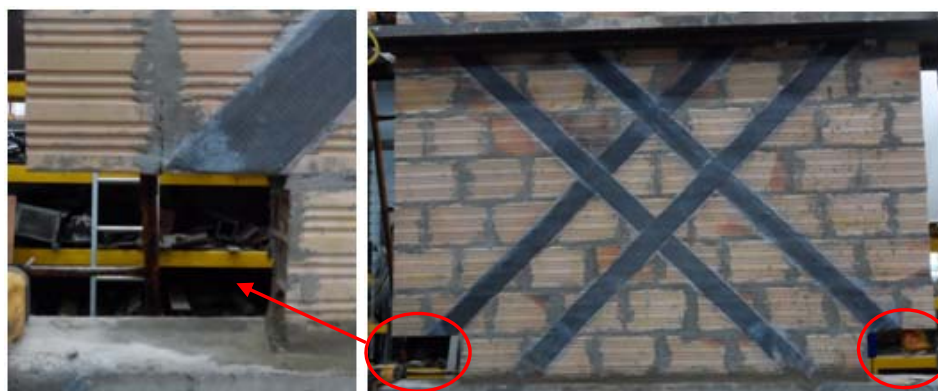
1) Con la ayuda de una sierra o cortadora y herramienta menor, eliminar los dos ladrillos de las esquinas inferiores del muro.
