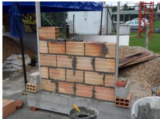
5) Traba adecuada en los muros, evitando aparejo petaca.
