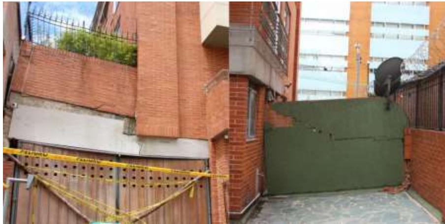
Figura 5: Edificios en Chicó Norte. (Bedoya, 2019).
