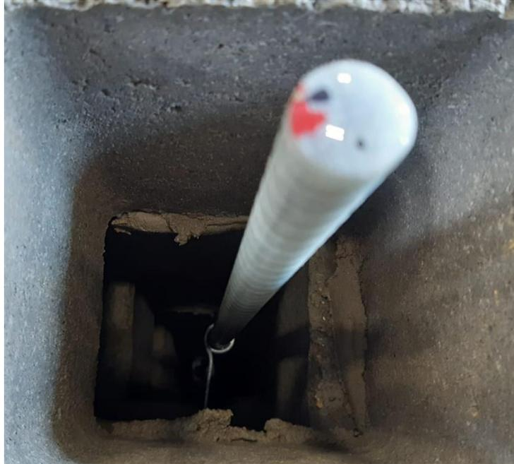
*Foto 1. Centralizadores utilizados durante el proceso constructivo*
