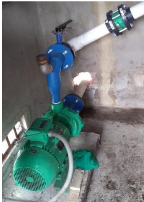
Figura 27 Motor y bomba de riego cultivo la Calera
