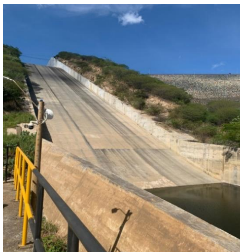
Figura 18. Vista del aliviadero. Fuente: (Avila, 2021)
