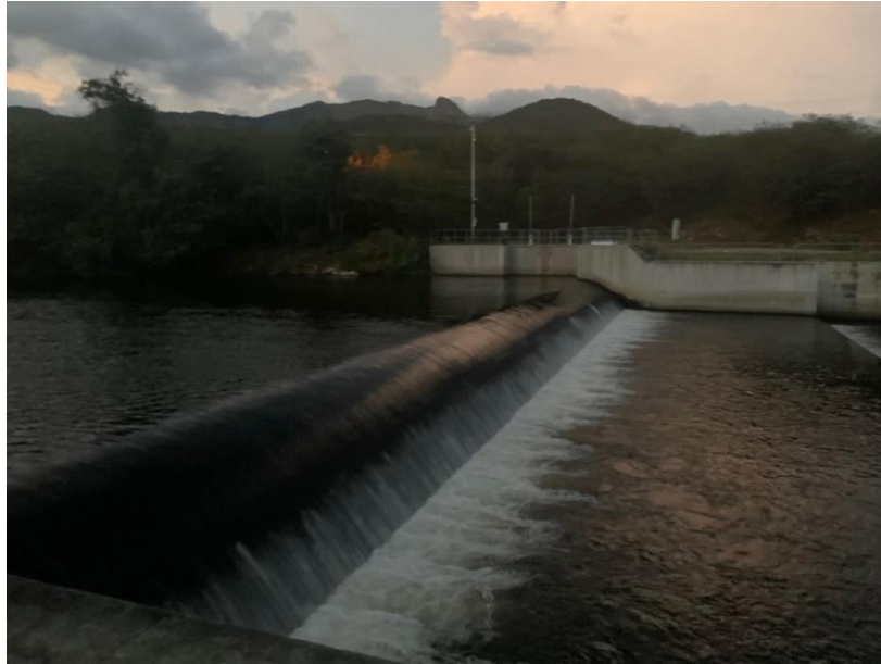
Figura 19. Presa derivadora. Fuente: (Avila, 2021)
