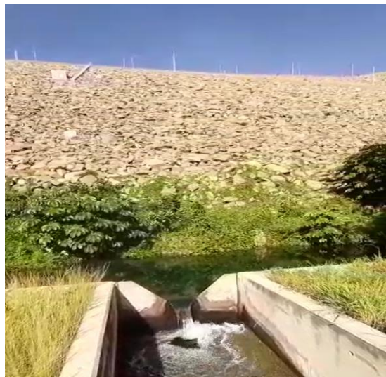
Figura 34. Sistema de medición de infiltración en embalse El Cercado. Fuente: (Avila, 2021)
