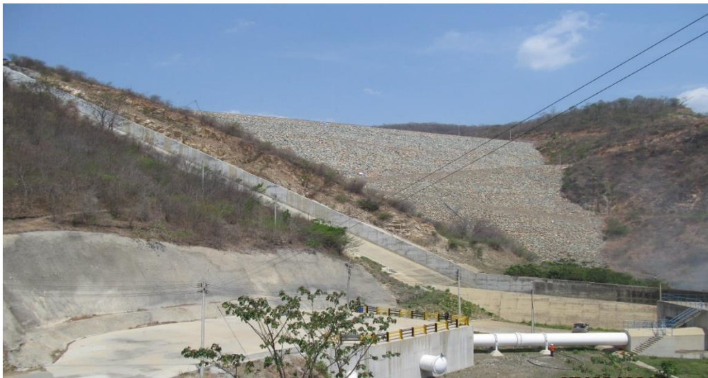
Figura 16. Vista de la presa El Cercado. Fuente: (ADR A. d., 2021)
