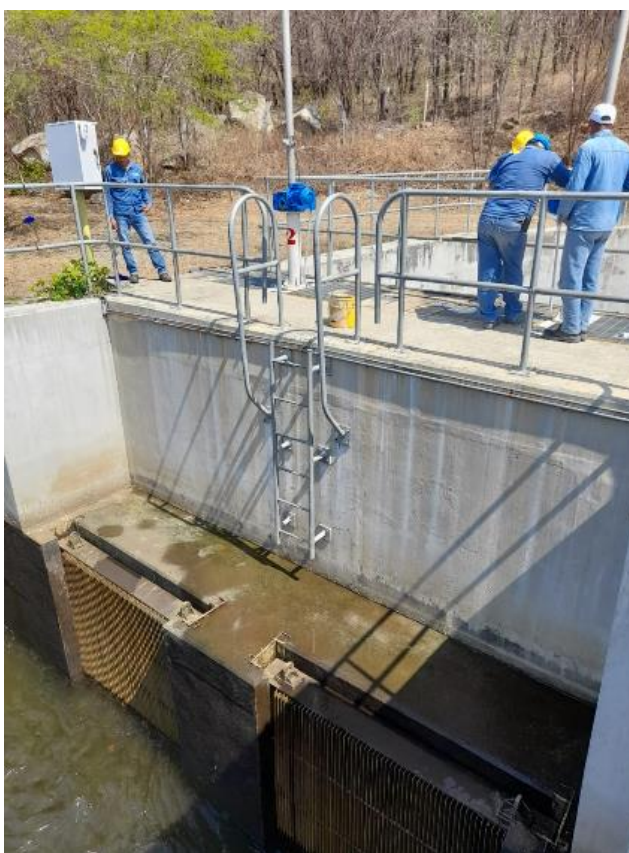
Figura 20. Canal de aducción de la conducción Ranchería Fuente: (Avila, 2021)
