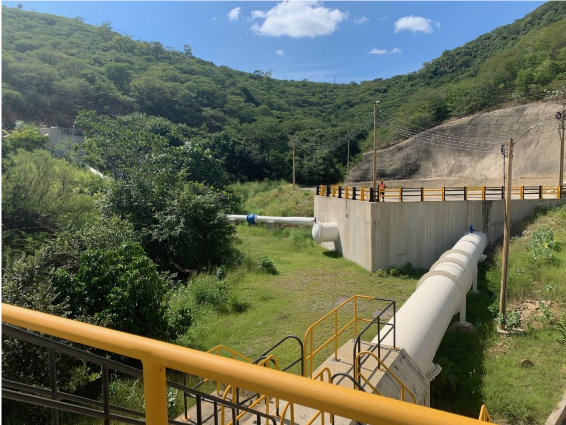
Figura 22. Sistema distribuidor (Deriva a la conducción San Juan. PCH y Descarga Howell Bunger.
