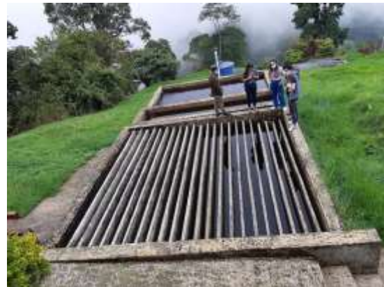
Imagen 12 . Floculador hidráulico de flujo horizontal PTAP San Antonio Santa Bárbara.
