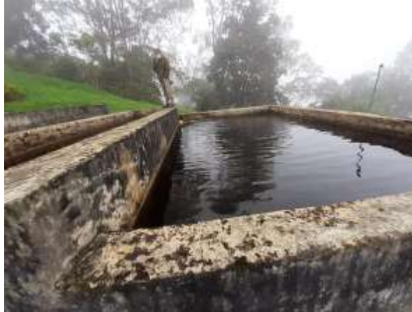
Imagen 20 Almacenamiento de agua para lavado del filtro. Fuente: Autor
