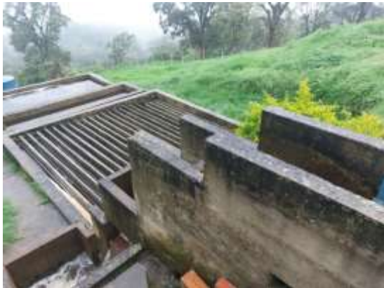
Imagen 12 . Floculador hidráulico de flujo horizontal PTAP San Antonio Santa Bárbara.
