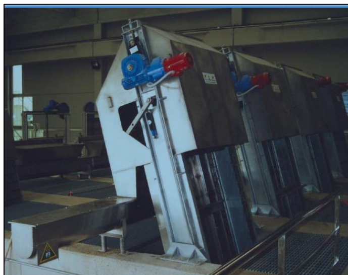
Ilustración 5 Rejilla mecánica
