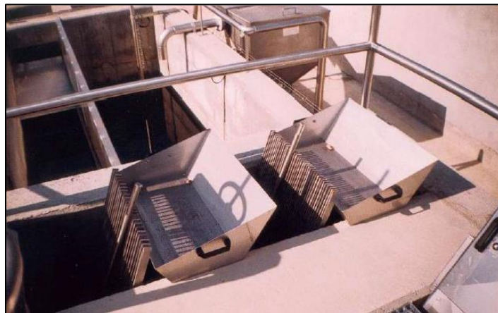
Ilustración 5 Rejilla mecánica
