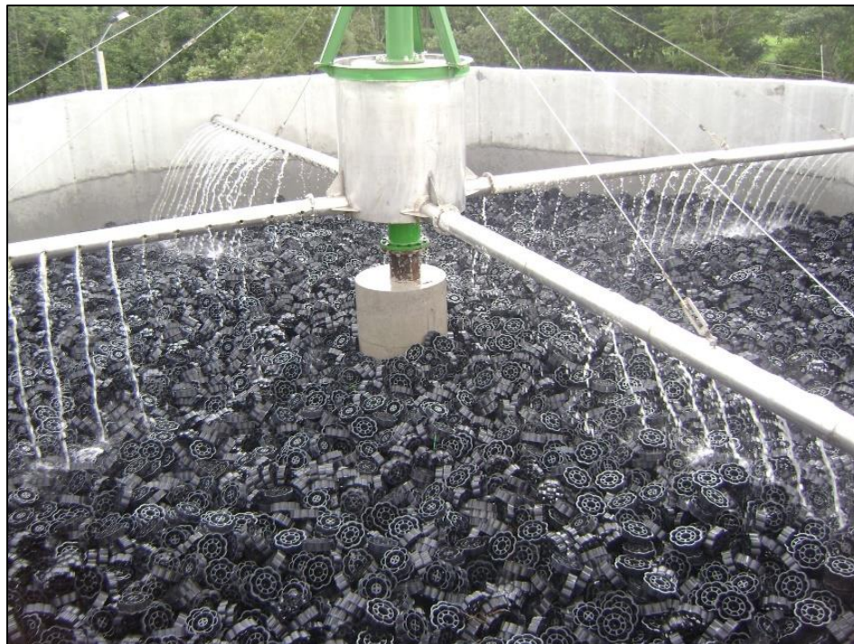
Ilustración 7 Disposición y distribución de flujo Filtro percolador
