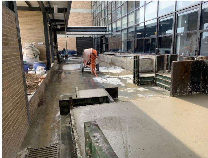
Ilustración 7. fundida de losa y vigas.
