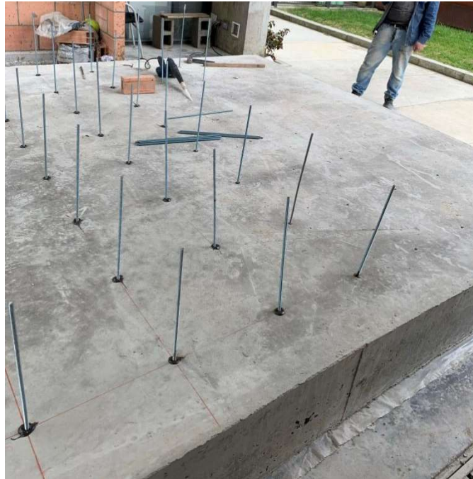
Ilustración 11. Instalación de Anclajes adheridos para ensayos a tensión.
