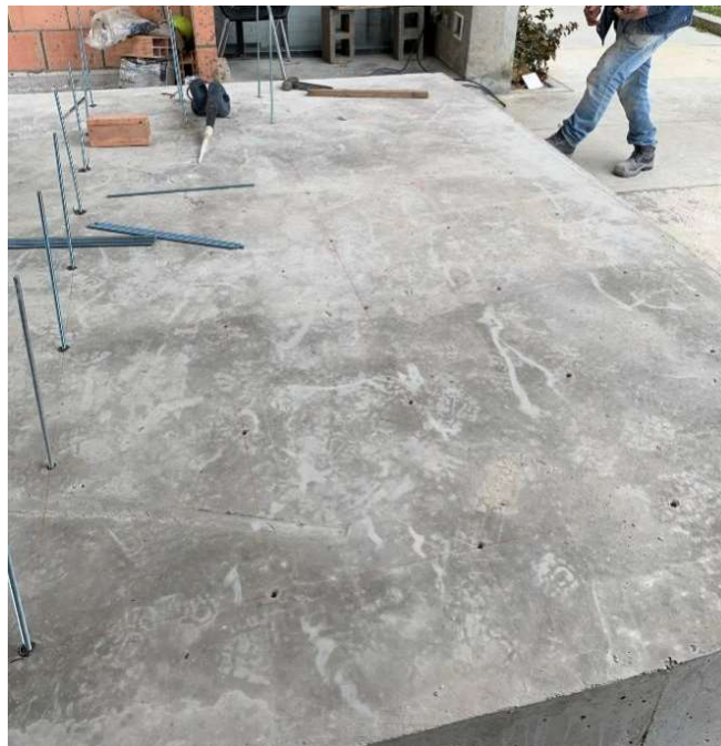
Ilustración 10. Perforaciones en losa con Replanteo usando Cimbra de mineral rojo.
