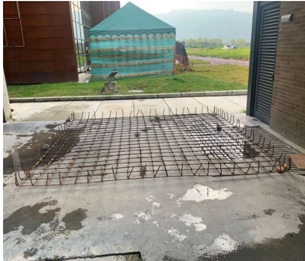
Ilustración 3. Refuerzo inferior de losa para ensayos a tensión
