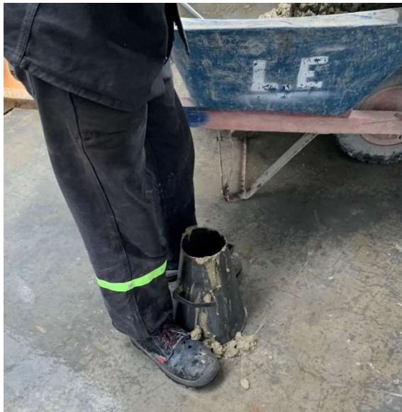
Ilustración 4. Ensayo de asentamiento del concreto
