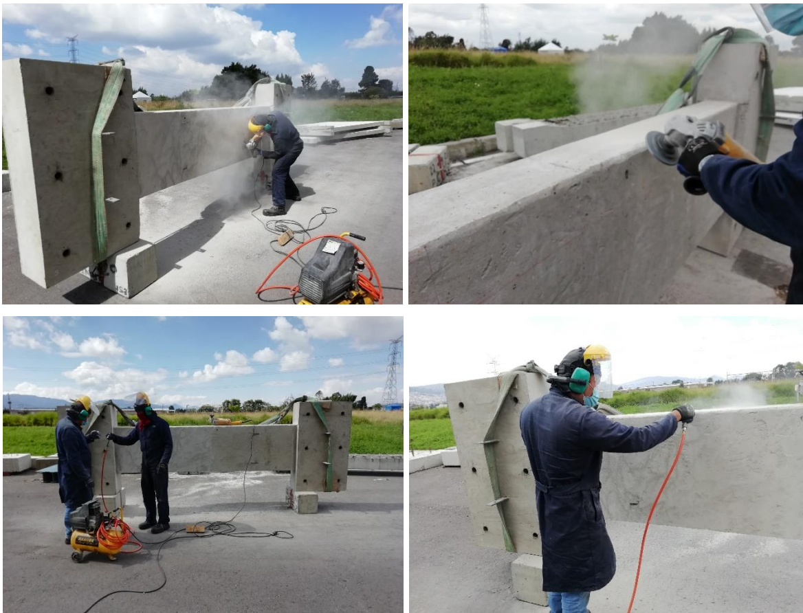
Figura 4.14. Preparación de la superficie
