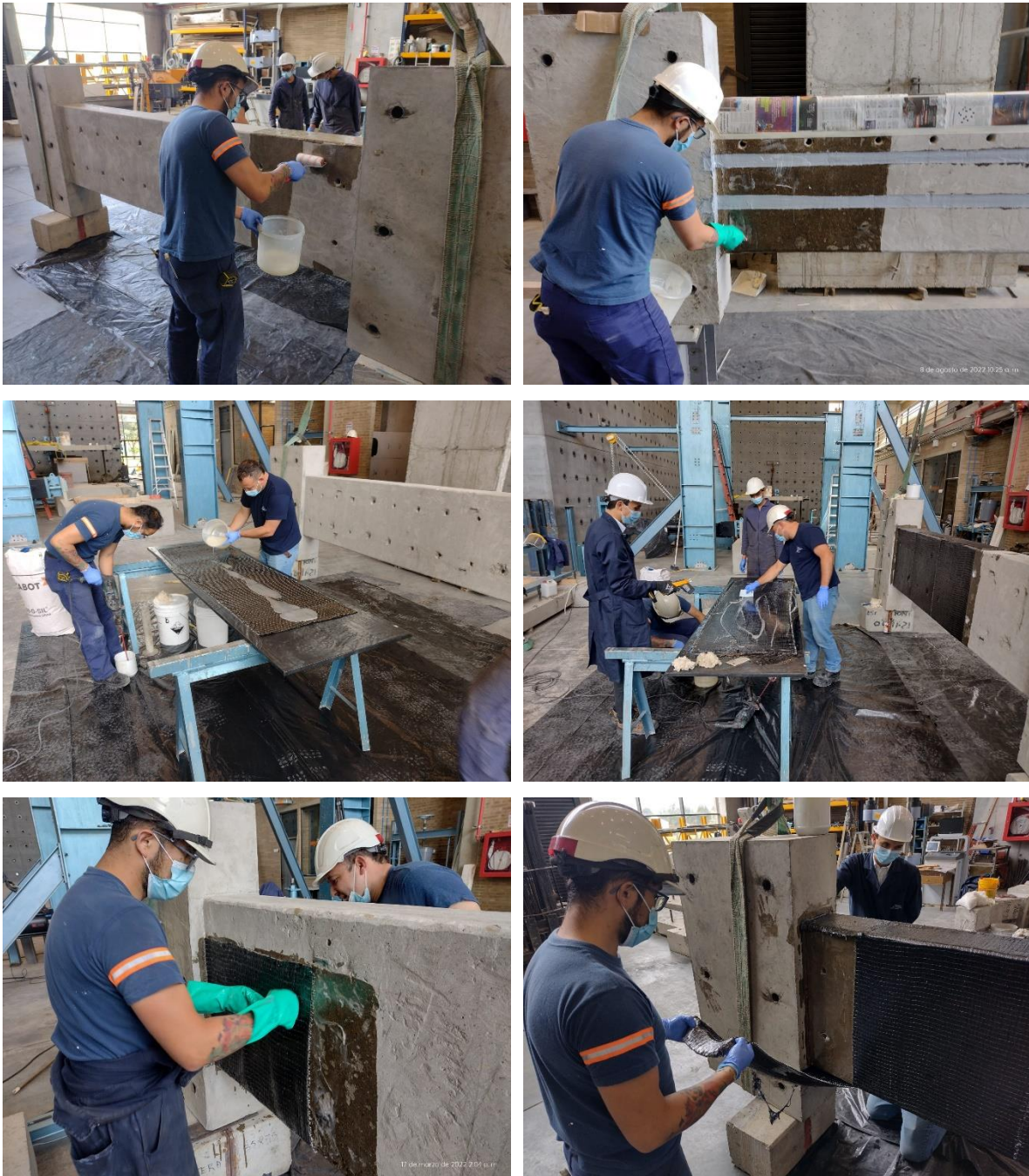
Figura 4.20. Instalación de tejidos FRP
