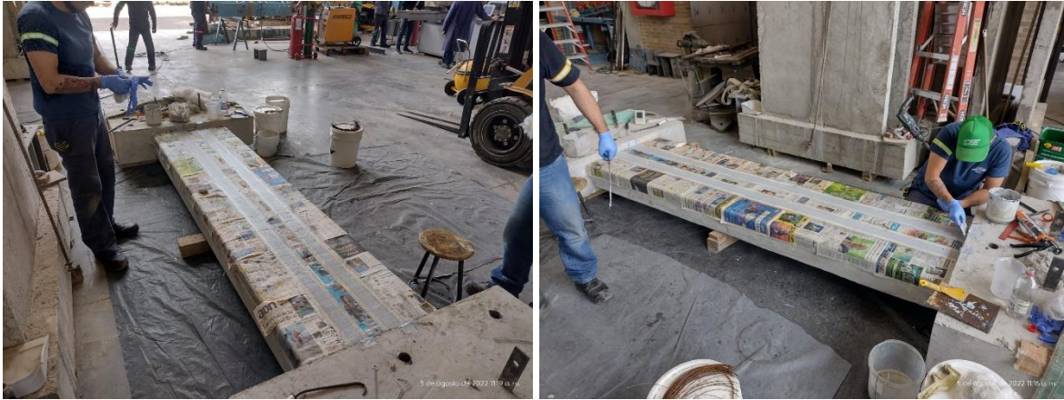
Figura 4.19. Instalación de refuerzo adicional de acero
