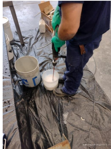
Figura 4.17. Preparación V-Wrap 770
