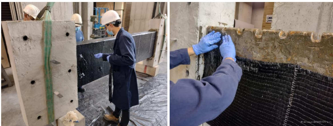
Figura 4.21. Instalación de sistemas de anclaje V-Wrap HM
