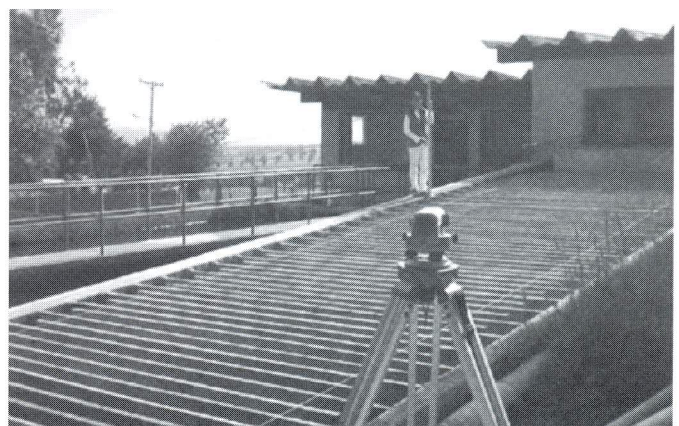
Figura 4. Nivelación del floculador.
