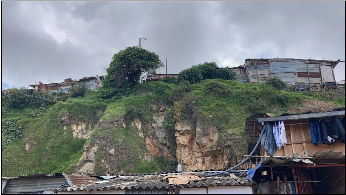
Figura 3.30. Fotografía de las zonas de escarpe con pendientes mayores a 45° de un antiguo frente de explotación minera.
