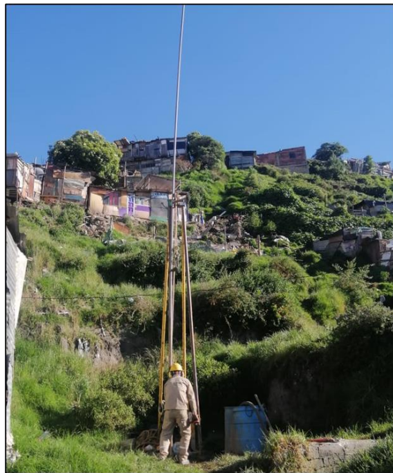
Figura 3.33. Fotografía de la zona donde se observan múltiples escarpes de deslizamiento al costado oriental del barrio mirador de Corinto.
