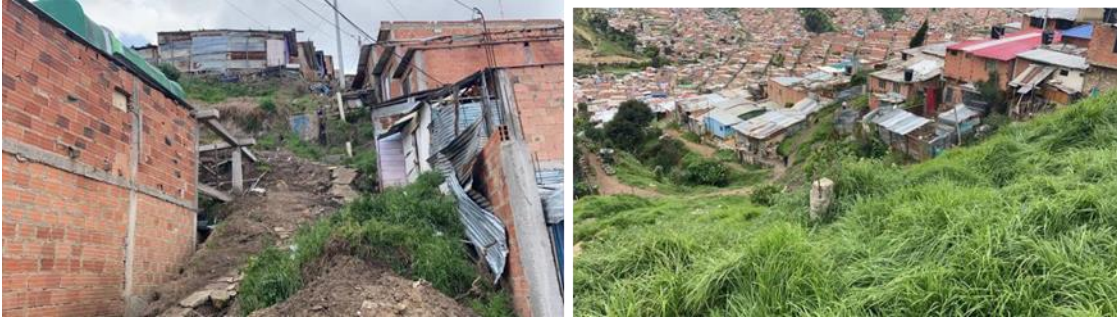
Fotografía 1.3. Vista viviendas en ampliación o construcción nueva. Fuente: Propia.
