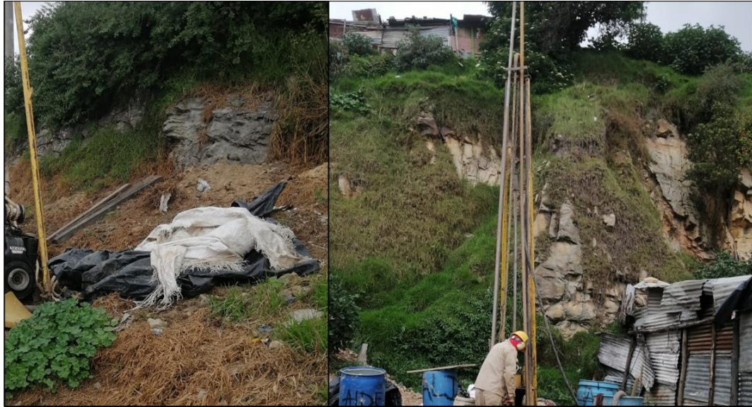
Figura 3.29. Fotografía de dos zonas en las que se presentan pendientes mayores a 45° por la presencia de caída de bloques de roca, en las cuales el escarpe puede haber sido por efecto de explotación de materiales, donde posteriormente se construyeron viviendas en el patio de dicha explotación.
