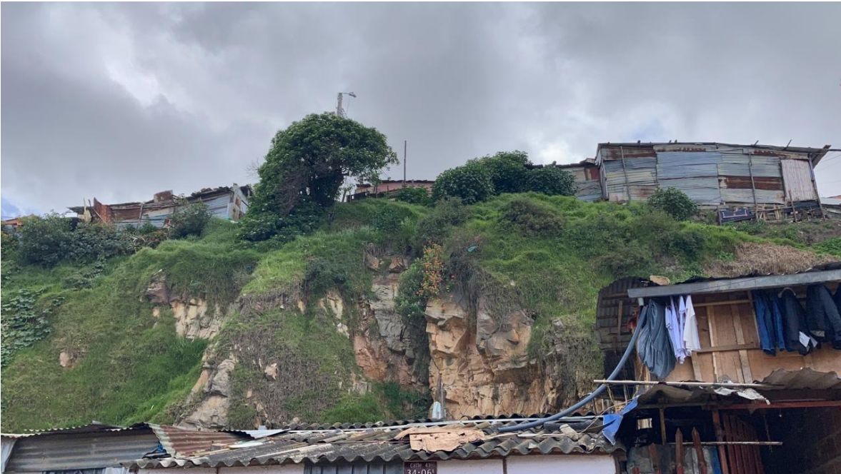
Fotografía 1.6. Vista de los asentamientos en la parte alta y baja de escarpes dejados por canteras abandonadas. Fuente: Propia.
