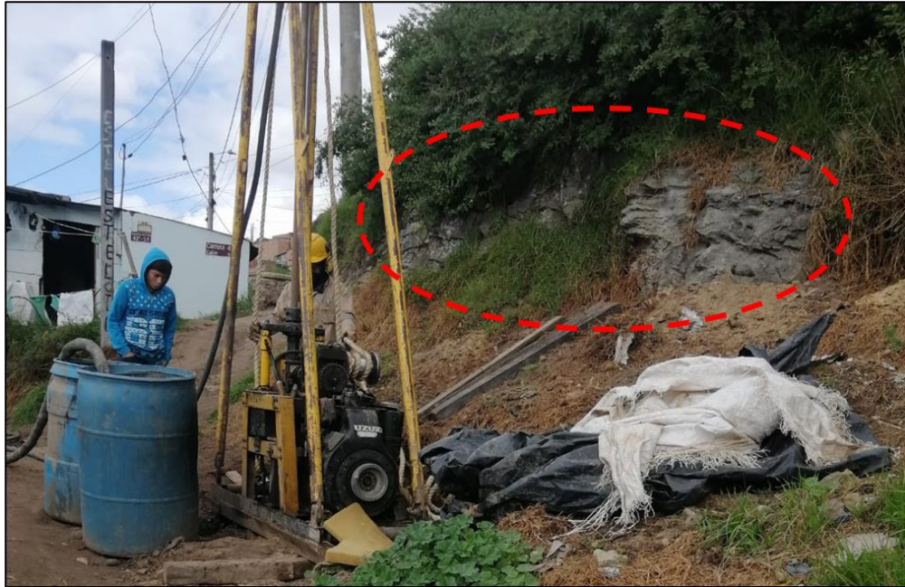
Figura 6.2. Fotografía del registro tomado durante la exploración directa donde se evidencia la roca meteorizada.
