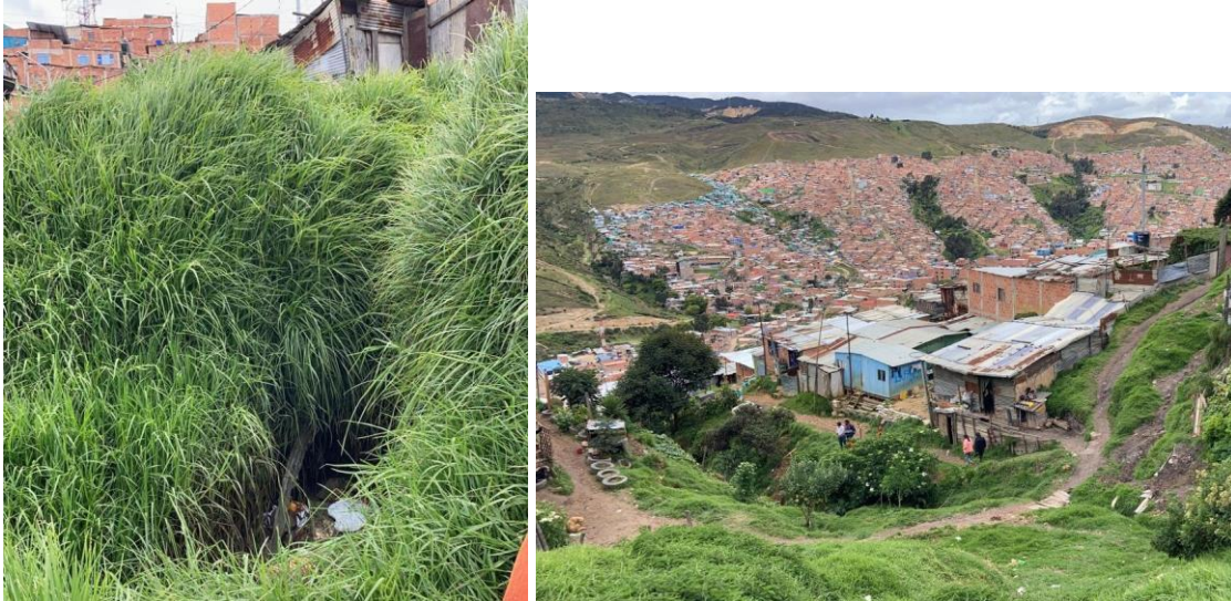
Fotografía 1.7. a) Vista del vertimiento de aguas lluvias y servidas sobre la ladera b) Drenaje natural que conduce las aguas a la Laguna Terreros. Fuente: Propia.
