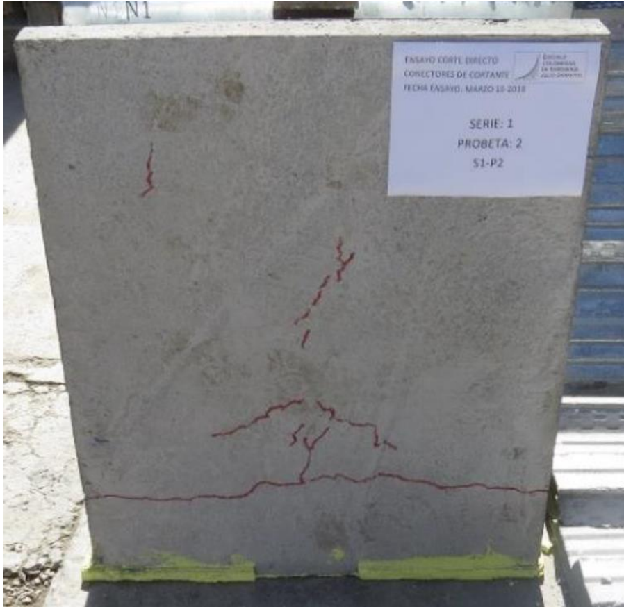
Figura 144. Fisuración de la Losa de Concreto Reforzado (2) – (Rodríguez R.M.,2019).
