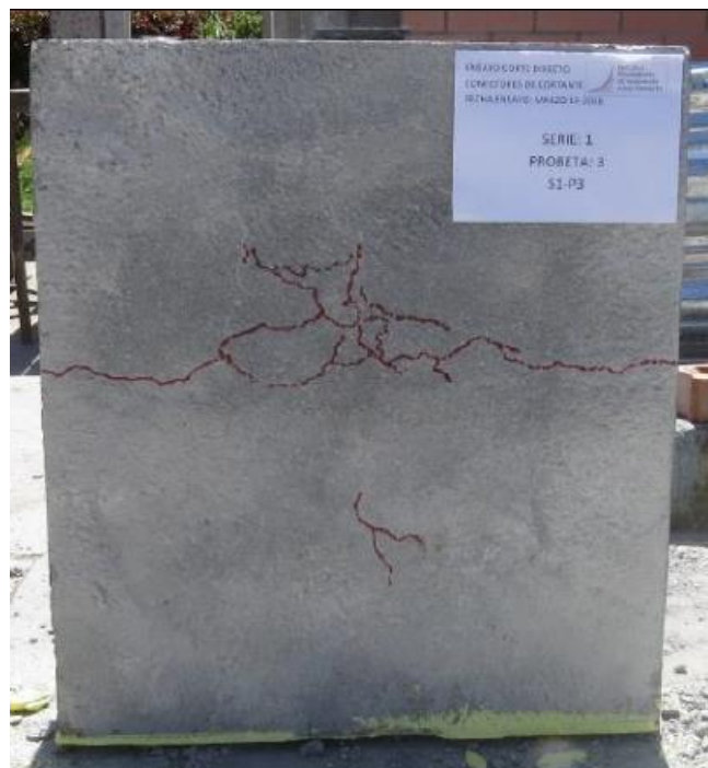
Figura 143. Fisuración de la Losa de Concreto Reforzado – (Rodríguez R.M.,2019).
