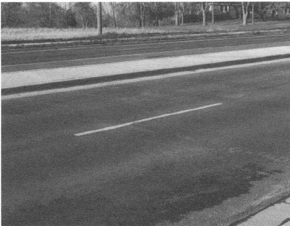
Figura 1. Carpeta de concreto asfáltico segregada.
