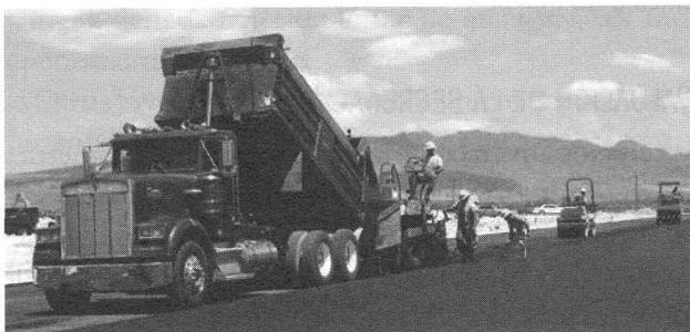
Figura 32. Intervención manual mínima tras la pavimentadora.
