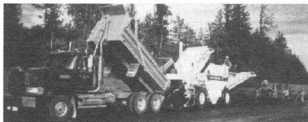
Figura 19. Vehículo para la transferencia de la mezcla<sup>9</sup>.
