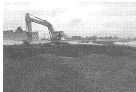
Fotografía 1. Centro de acopio de RAP, Instituto de Desarrollo Urbano.
