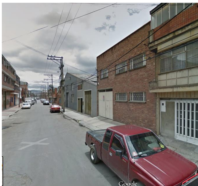
Ilustración 69 Fachada del lugar a implementar el proyecto
