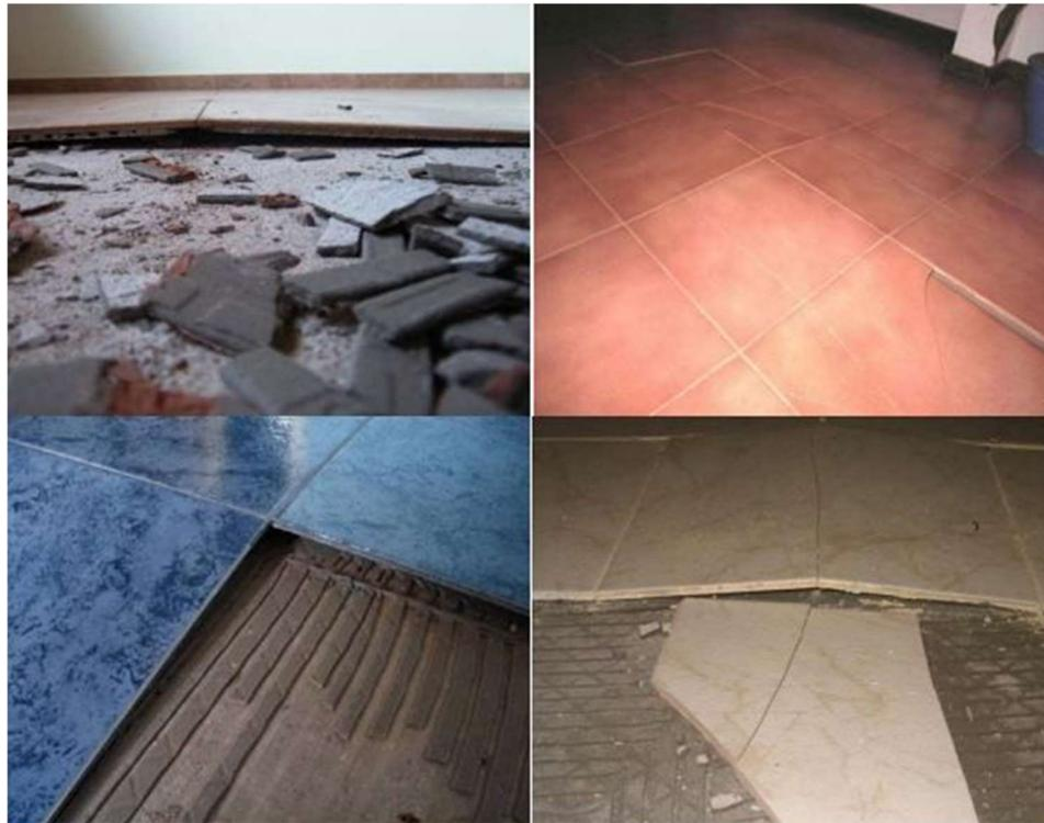
*Ilustración 4 Fractura en acabados de piso
