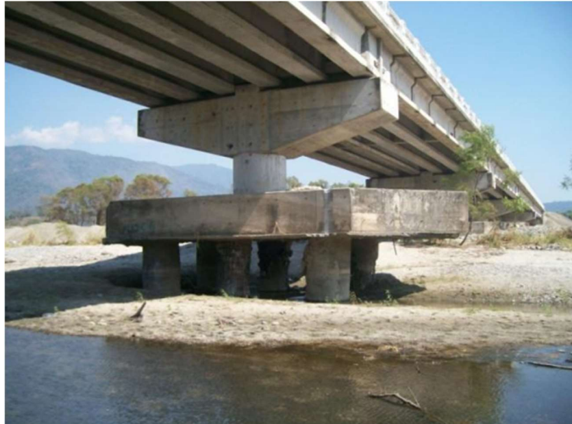
Ilustración 15 Descubrimiento de pilotes soporte de pila principal en puentes Fuente: (Sandoval, 2012)
