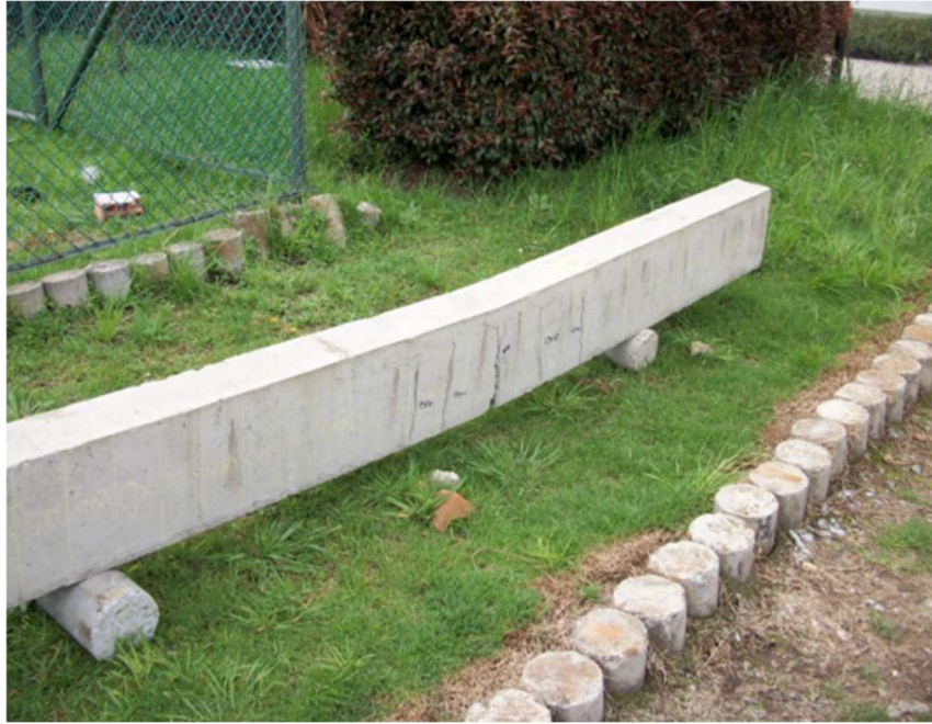
Ilustración 63 Falla a flexión (fisuras perpendiculares a la dirección del acero longitudinal) Fuente: (Beltran Riveros , 2011)
