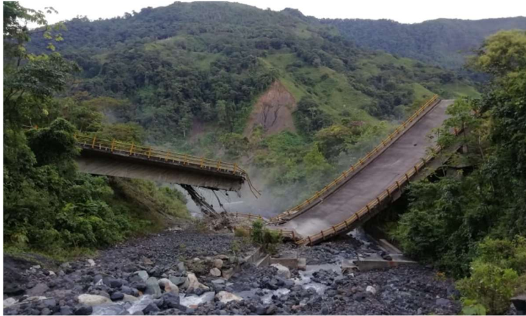
Ilustración 101 Colapso puente La Orquídea 1 Fuente: (Martha Cifuentes, 2019)
