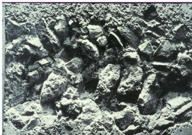
Ilustración 92 Desgaste en la pasta de cemento por cavitación. Fuente: (Arango Mejía, 2013)
