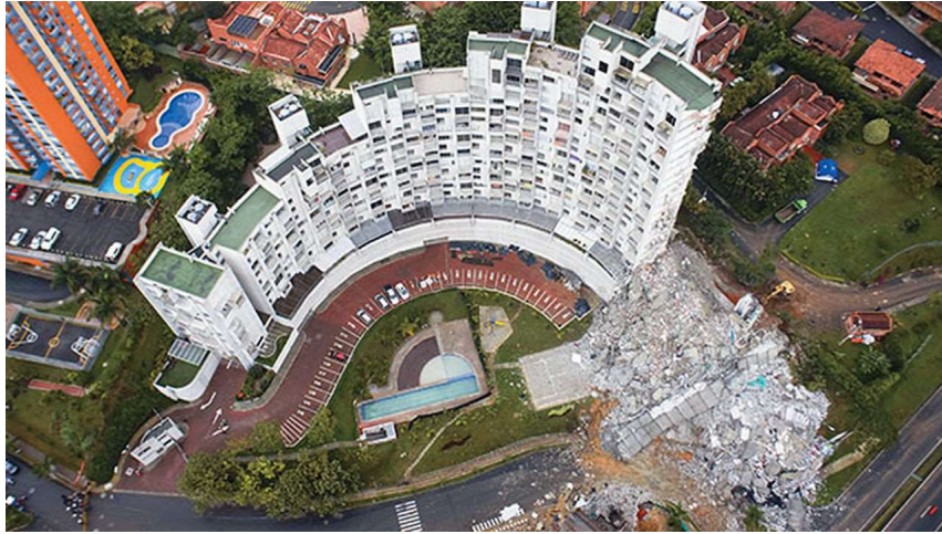
Ilustración 16 Falla de la torre 6 del edificio Space 12 de octubre de 2013, Medellín, Colombia.
