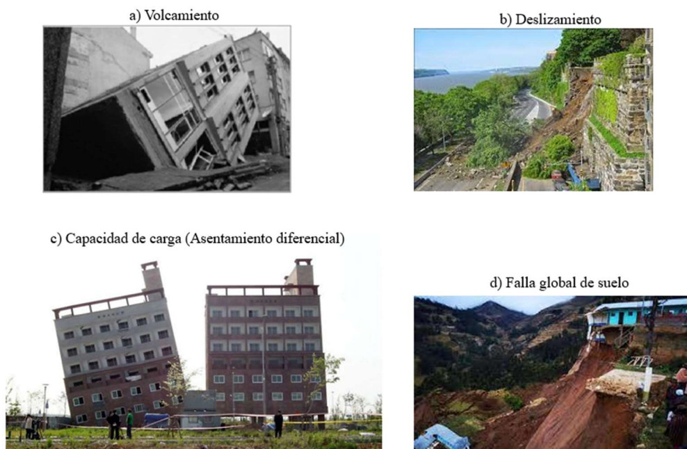
Ilustración 23 Fallas por estabilidad externa de estructuras Fuente: a) (Blanco, 2012); b) (La Terraza, 2013); c) (An Ingenieros y Consultores, 2021) & d) (RPP, 2019)
