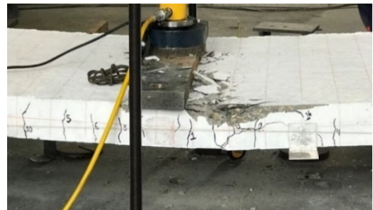
Fotografía 13. Falla aplastamiento del concreto.
