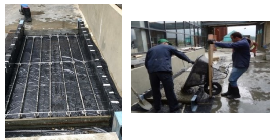
Fotografía 1. Construcción losa CFRP-6
