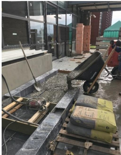
*Fotografía 3. colocación de refuerzos y fundida*
