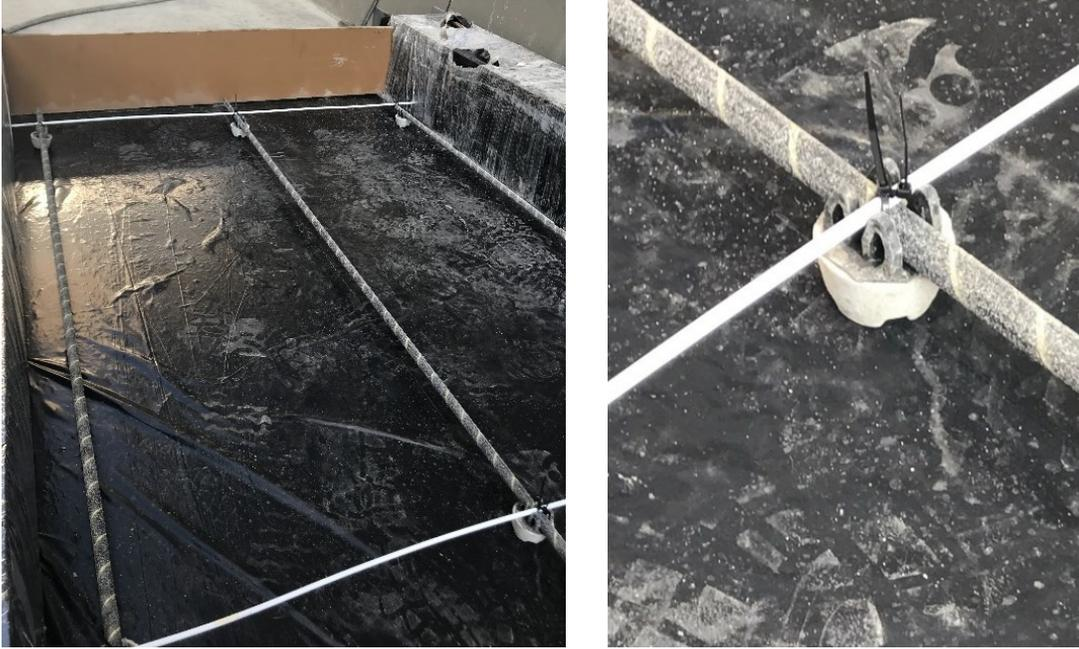
*Fotografía 4. colocación distanciadores del refuerzo*
