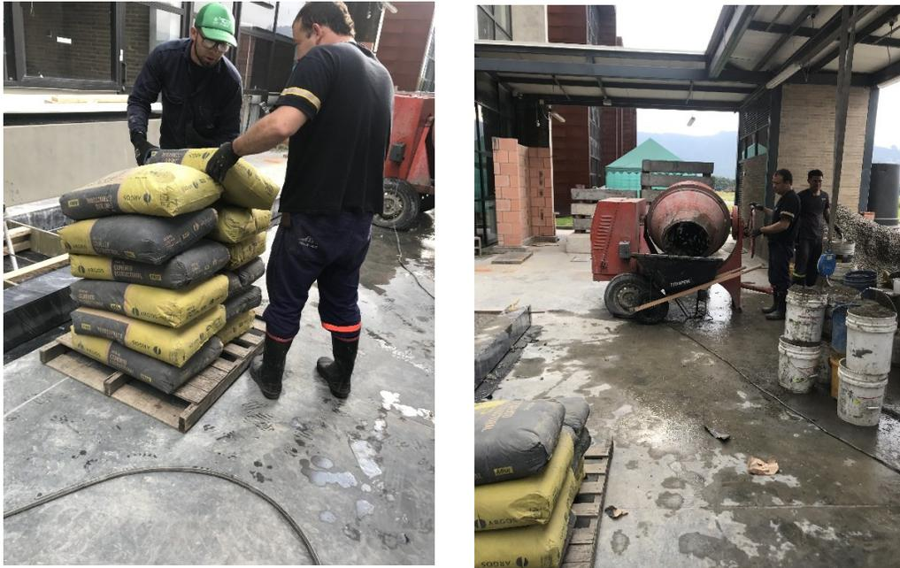
*Fotografía 53. Dosificación del cemento y agua, elaboración del concreto.*
