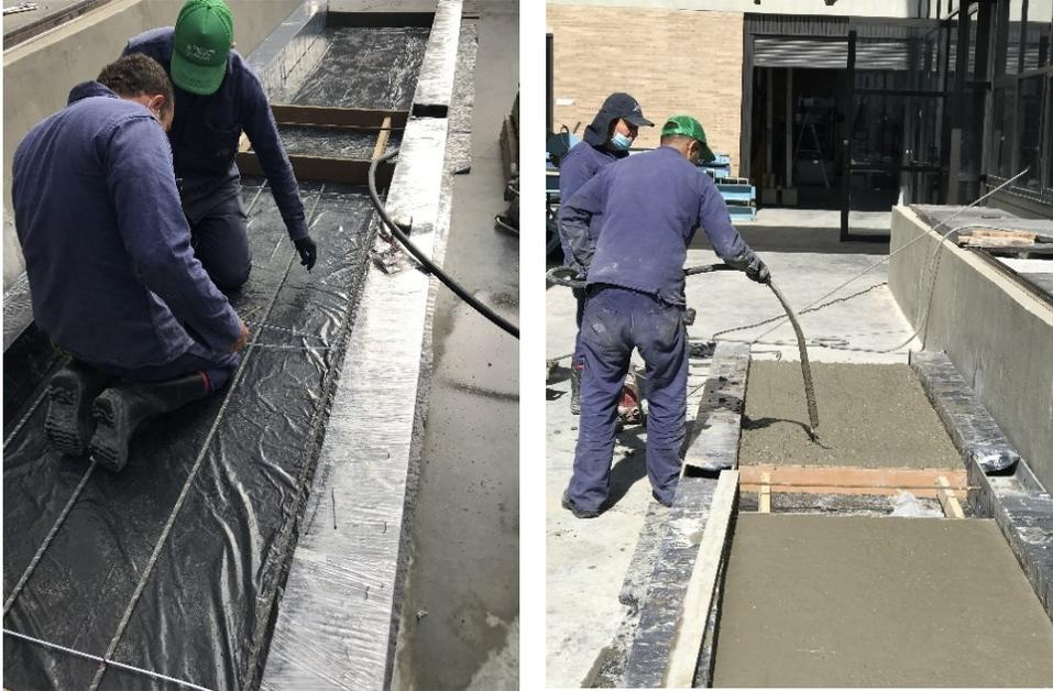
*Fotografía 6. Vaciado y vibrado del concreto*
