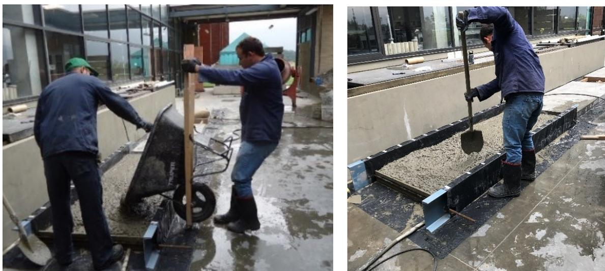
*Fotografía 10. Vaciado y conformación mezcla de la losa CFRP-6*
