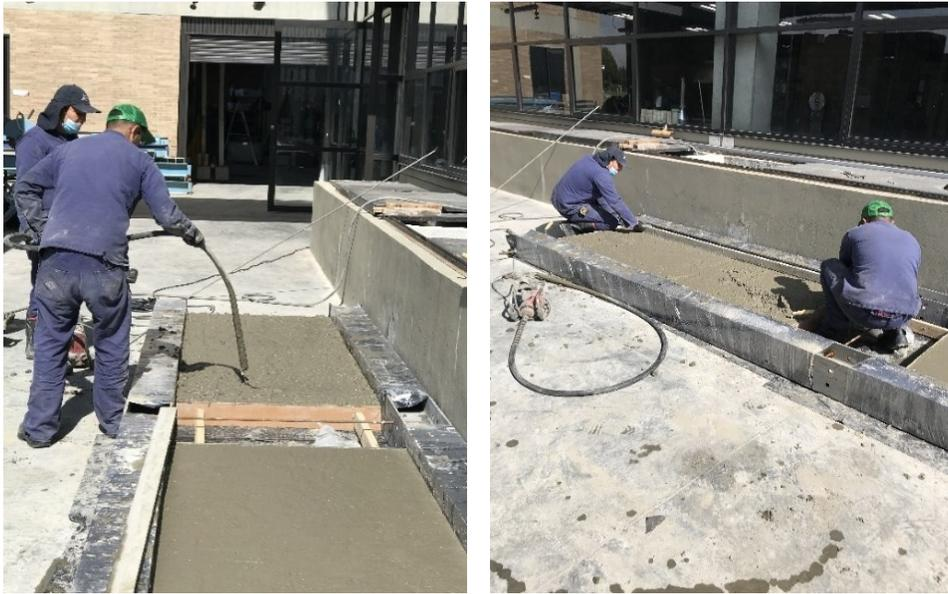
*Fotografía 8. Vibrado y afinado Losa CFRP-5*
