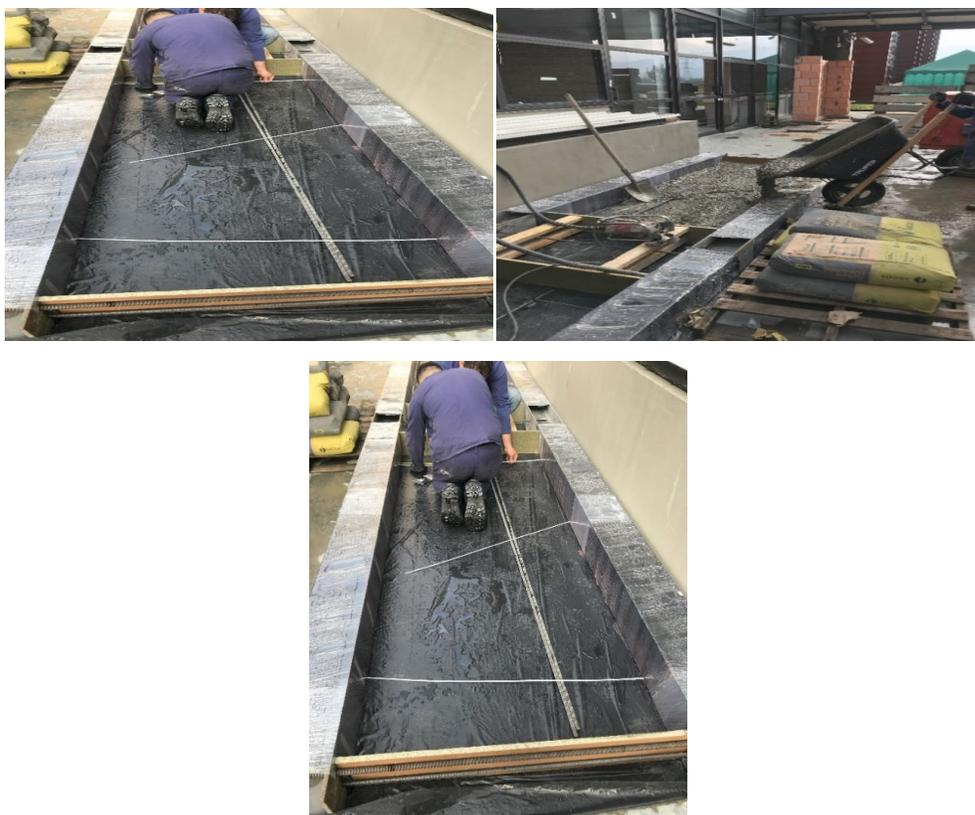
*Fotografía 56. Construcción de losas de ensayo A706-1, formaleta, refuerzo y vaciado de concreto*
