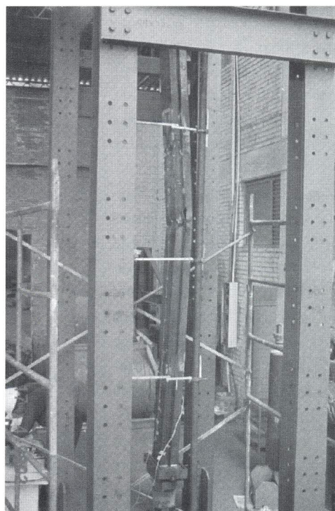
Figura 5. Pandeo general de una columna de 4.200 mm.
