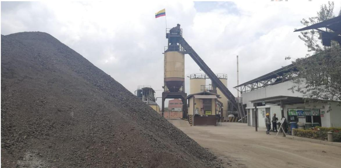
*Figura 19 Vista de la planta de la Entidad 4 con el acopio de RAP*
