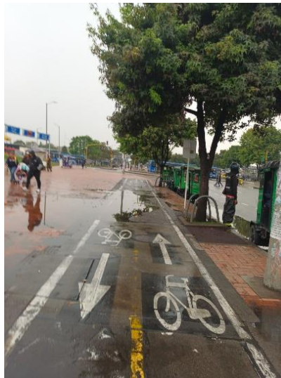
Figura 24. Calidad de los drenajes observados. Fuente: (Propia)
