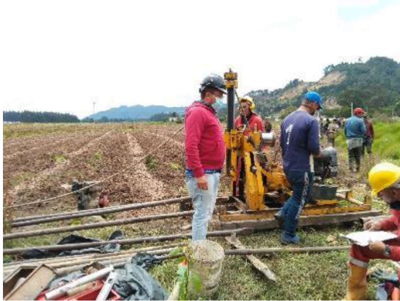
Figura 28. Ejecución del Sondeo 3, profundidad de 20.0 m.
