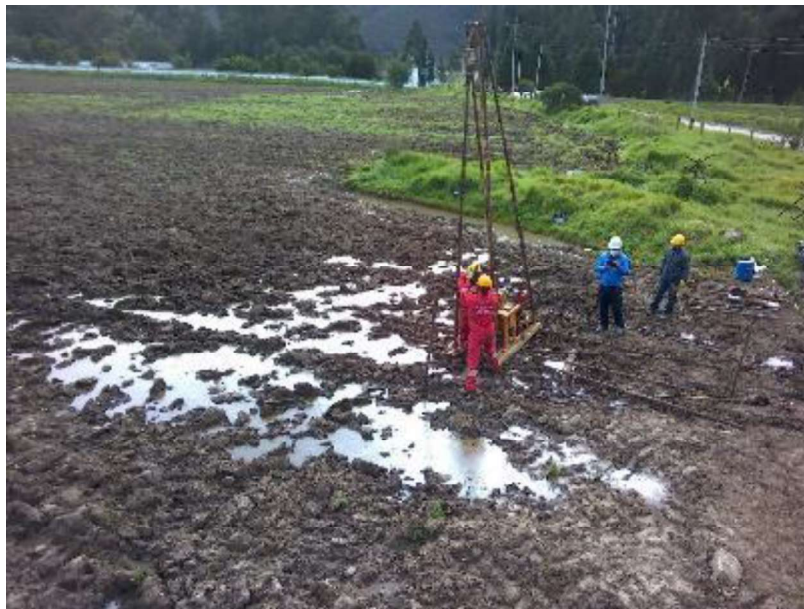
Figura 27. Ejecución del Sondeo 2, profundidad de 20.0 m.
