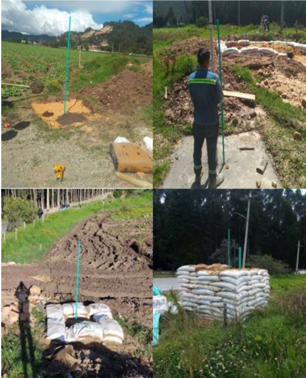
Figura 60. Construcción del Modelo Físico 1 sin inclusión rígida.
