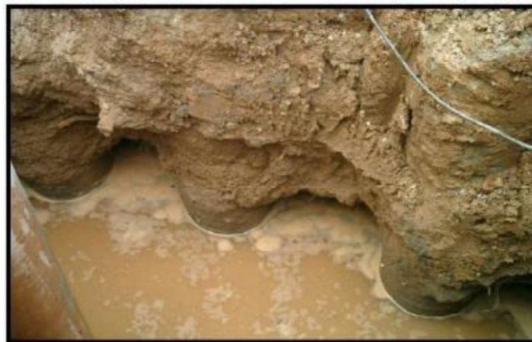
Figura 12. Columnas Mixpile bajo freático. Fuente Coronilla (2015).
