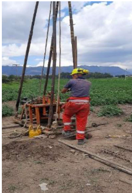
Figura 29. Ejecución del Sondeo 4, profundidad de 16.50 m
