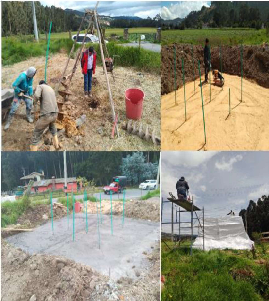
Figura 68. Construcción del Modelo Físico 3 con grupo de 9 inclusiones rígidas.
