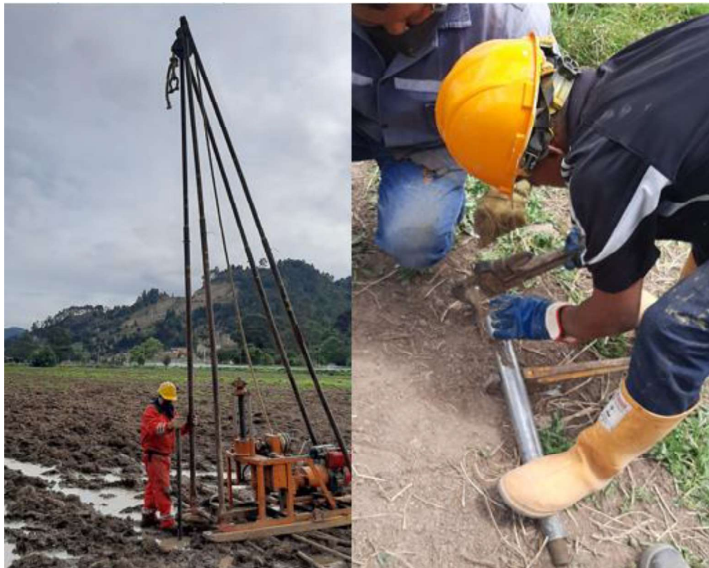
Figura 30. Ensayo de penetración estándar (SPT).
