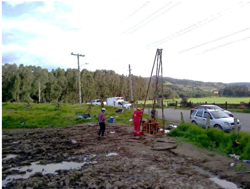
Figura 26. Ejecución del Sondeo 1, profundidad de 20.0 m.
