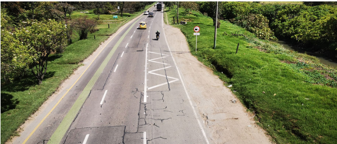
Ilustración 65. Foto 1 - Punto de descenso en la Autopsita Norte por Calle 207.
