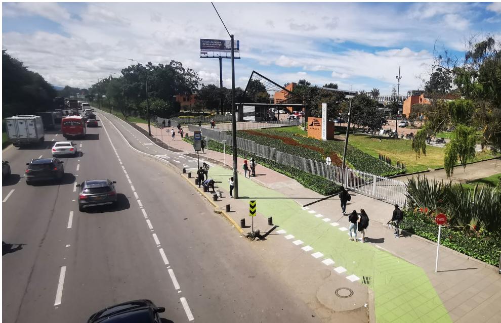
Ilustración 60. Acceso vehicular directo por la Autopista Norte a la E.C.D.I.J.G.
