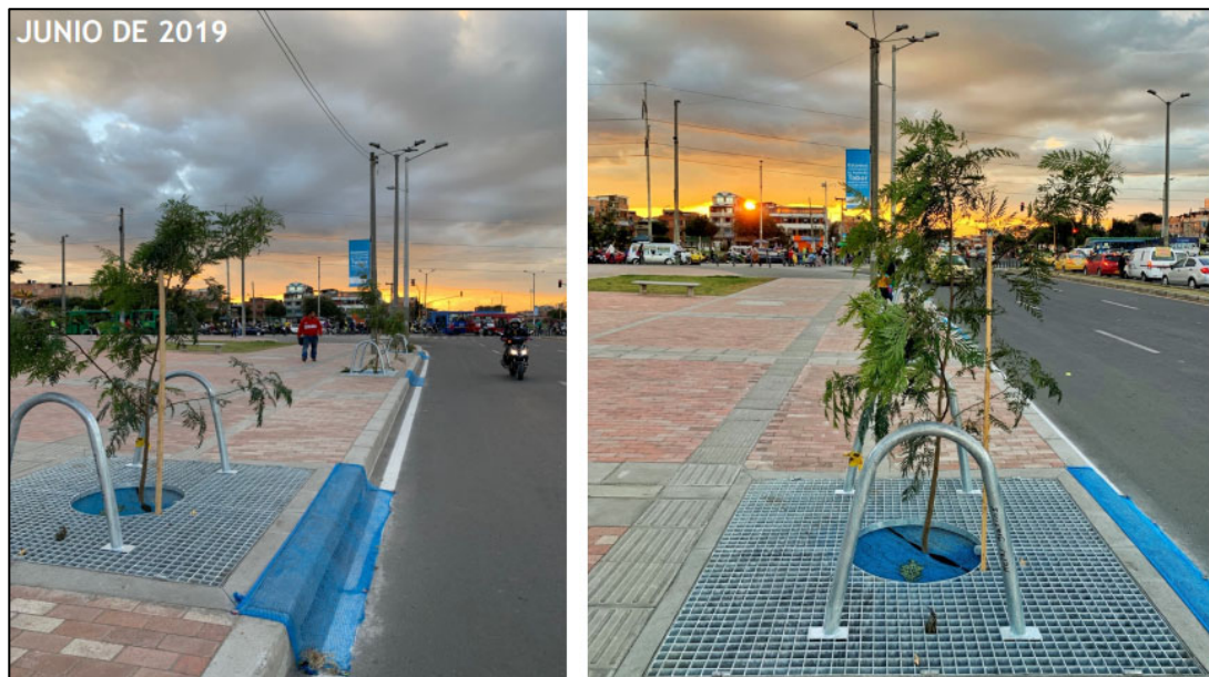
Ilustración 10. Primeras 3 tipologías de Alcorque inundable en Bogotá.
