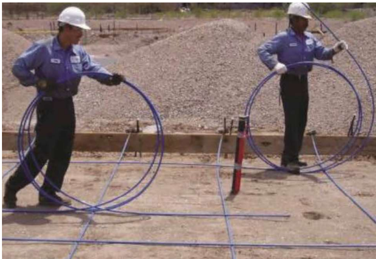
Figura 5.3. Instalación de Tendones.
