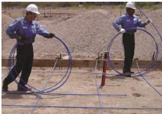
Figura 1.7. Instalación de tendones
