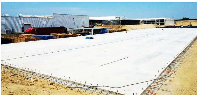
Figura 1.6. Losa postensada apoyada sobre el terreno
