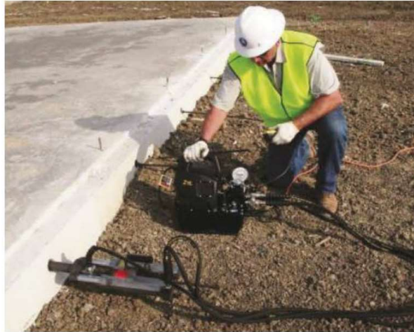
Figura 5.1. Operación de tensión del tendón.
