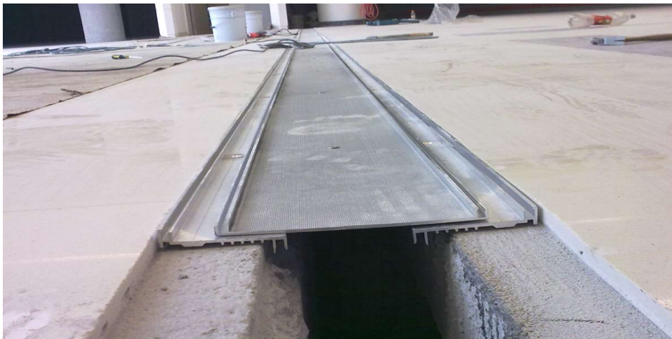
Figura 1.4. Juntas en losas de piso
