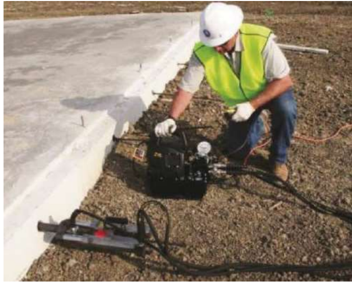
Figura 1.8. Operación de tensado del tendón
