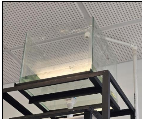
Ilustración 5-2. Tanque de distribución.
