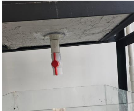
Ilustración 5-5. Válvula control del efluente.
