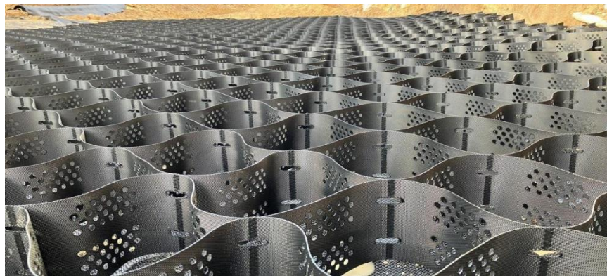
Figura 7: Geocelda como refuerzo, vías internas Bogotá (Pavco Wavin Geosintéticos)
