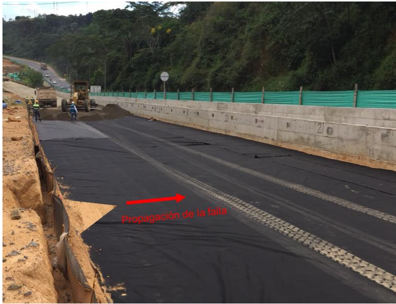
Figura 32: Rasgado trapezoidal sobre un geotextil tejido (elaboración propia)
