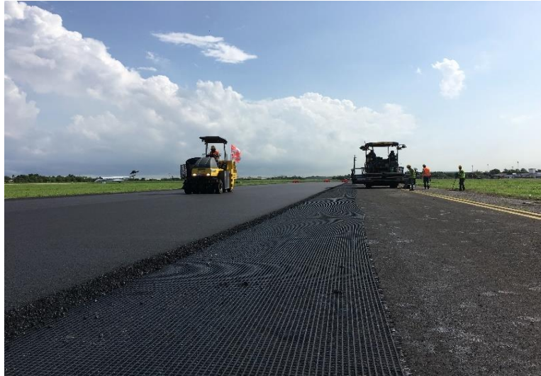
Figura 9: Geomalla de fibra de vidrio para repavimentación, Aeropuerto Barranquilla (Pavco Wavin Geosintéticos)
