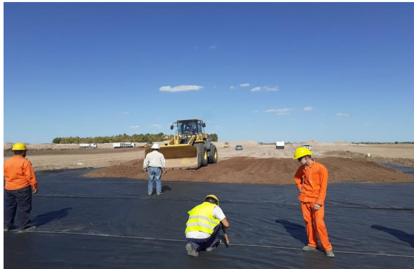
Figura 5: Geotextil tejido aplicado a separación, terraplenes PETAR Mendoza Argentina (Pavco Wavin Geosintéticos)
