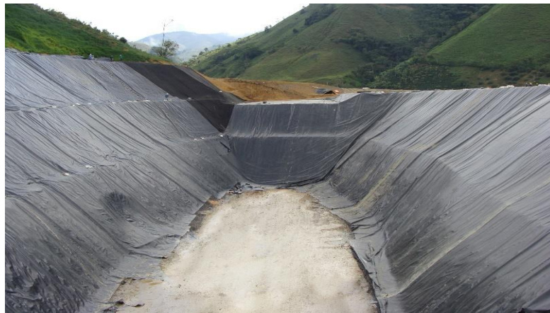
Figura 10: Impermeabilización con geomembrana, minera el Roble (Pavco Wavin Geosintéticos)
