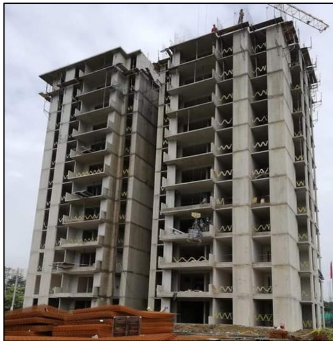
Figura 33. Edificaciones típicas de categoría Alta Fuente. Google Maps,2020.
