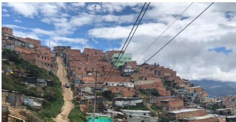
Ilustración 16. Panorámica de las edificaciones en barrio mirador de corinto (Elaboración propia, 2024)
