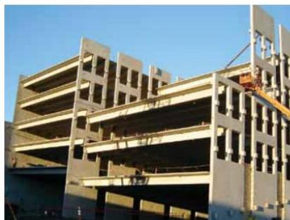
Ilustración 86 – Muros prefabricados usados para estructuras de parqueo. Fuente: (Precast/Prestressed Concrete Institute, 2010)
