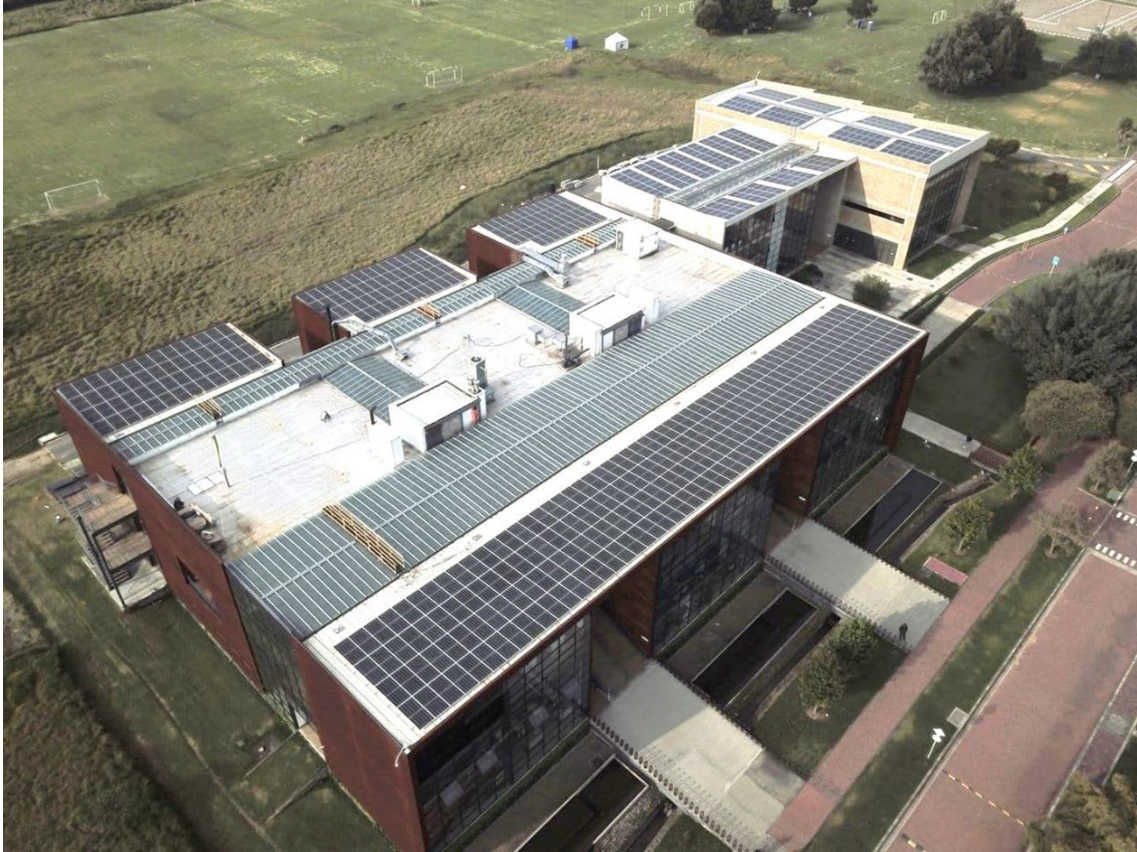
Ilustración 20 Planta Solar Fotovoltaica Universidad Escuela Colombiana de Ingeniería Julio Garavito
