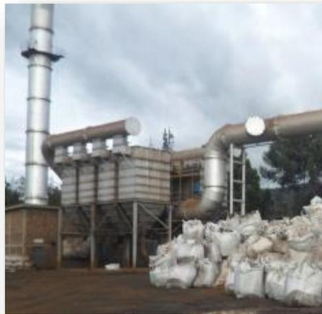
Ilustración 11. Sistema de depuración de emisiones mediante filtros de mangas.
