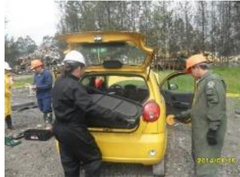
FASE III. Desmontaje de componentes interiores.
