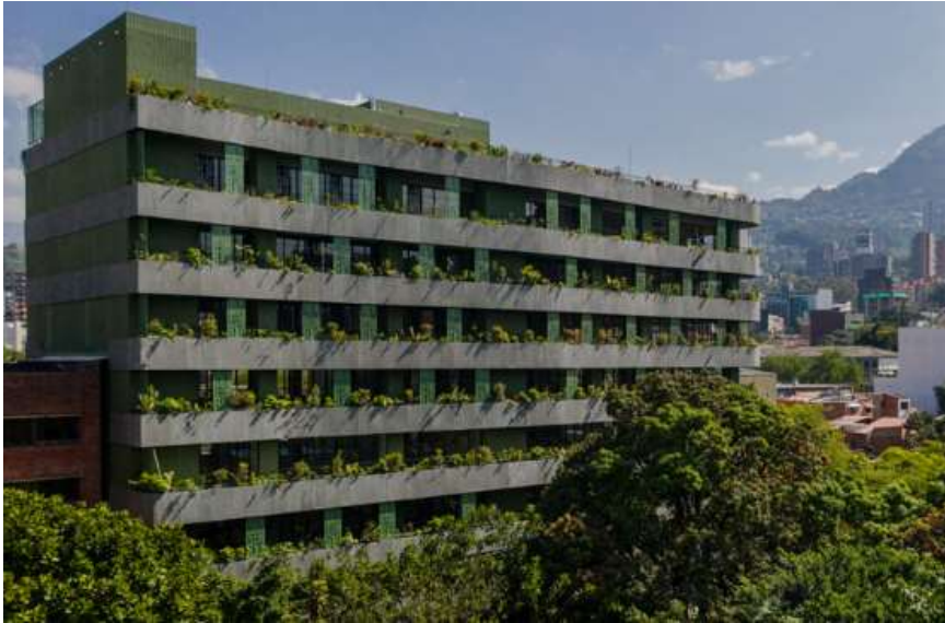
Figura 11-12 Fachada en UHPC Edificio Antejardín (Cimbrados, 2020).
