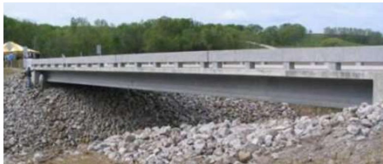
Figura 11-2 Primer puente en UHPC construido en Estados Unidos, Iowa – USA (Federal Highway Administration, 2013).
