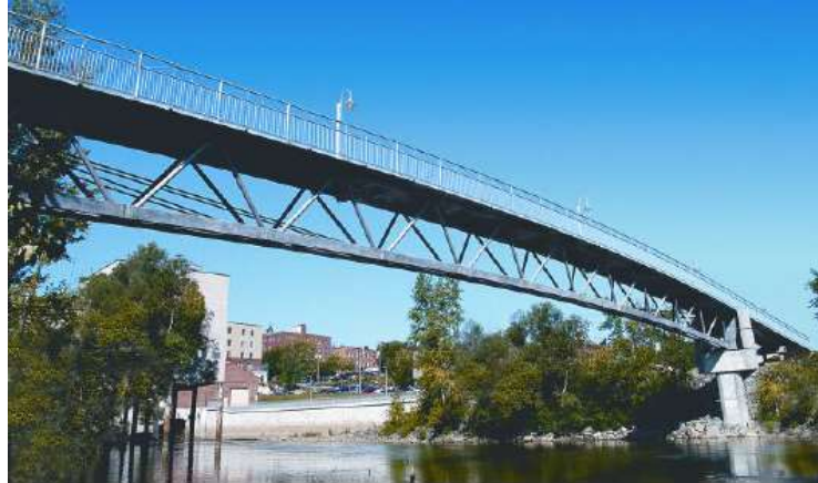
Figura 11-1 Primer puente en UHPC construido en el mundo, Quebec – Canadá (Federal Highway Administration, 2013).
