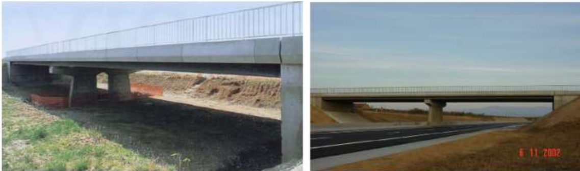
Figura 11-3 Primer puente tipo carretera en Valence - Francia (Toutlemonde et al., 2013).
