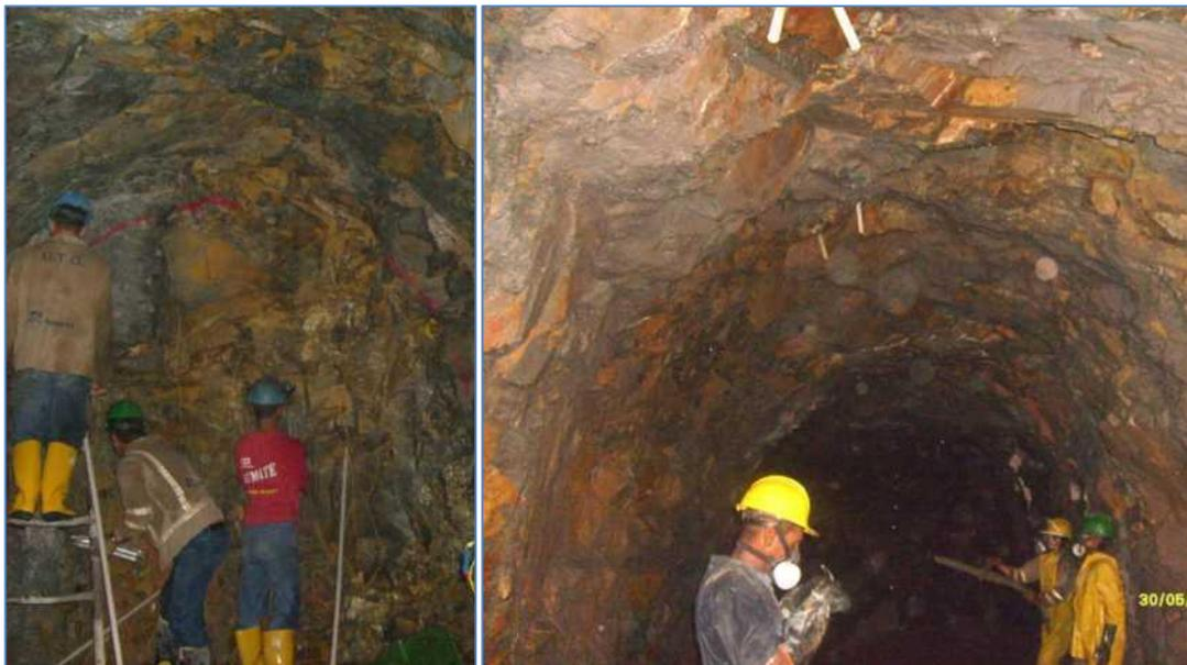
Foto No. 7 Instalación de explosivo para excavación.
