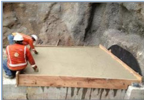
Foto No. 35 Construcción de losa de concreto sobre las tapas de la conducción.
