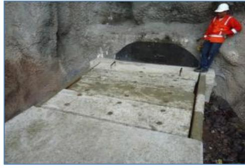
Foto No. 34 Levantamiento de tapa en cámara de transición del portal de salida del túnel 2
