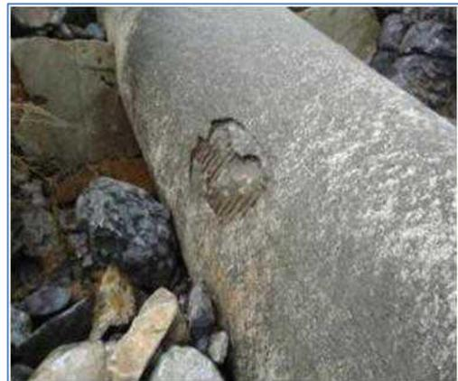
Foto No. 32 Daños en tubería por arrastre de material
