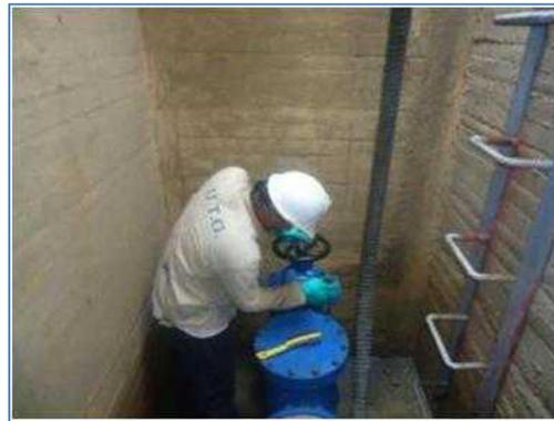
Foto No. 12 Válvula de compuerta y cheque del sistema de purga K9+129
