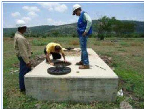
Foto No. 26 Revisión de valvula de mariposa, que sirve de cierre en la mitad de la conducción
