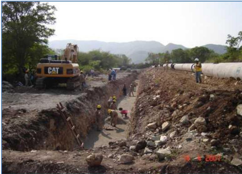
Foto No. 1 Excavación a cielo abierto, para instalación de tubería.
