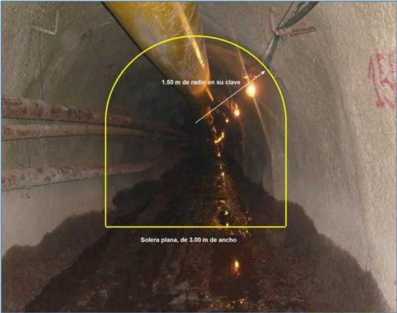
Foto No. 8 Sección de túnel construido
