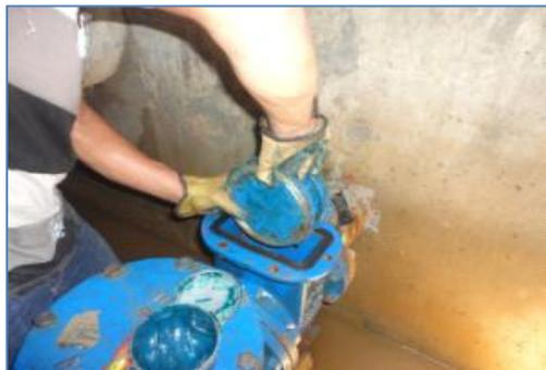
Foto No. 20 Desmontaje y limpieza purga K9+890
