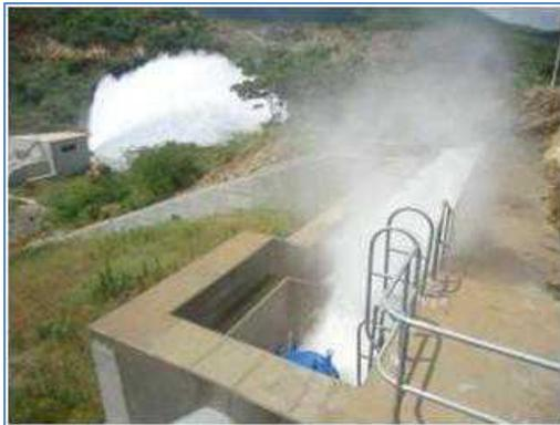
Foto No. 25 Llenado de tanque de amortiguación
