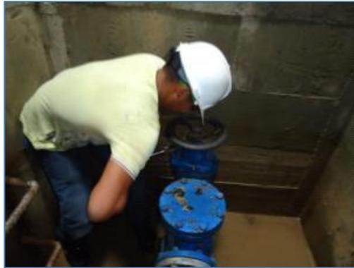
Foto No. 19 Desmontaje y limpieza purga K6+752
