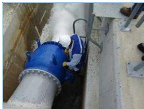
Foto No. 24 Apertura válvula de paso anular, taque de amortiguación.
