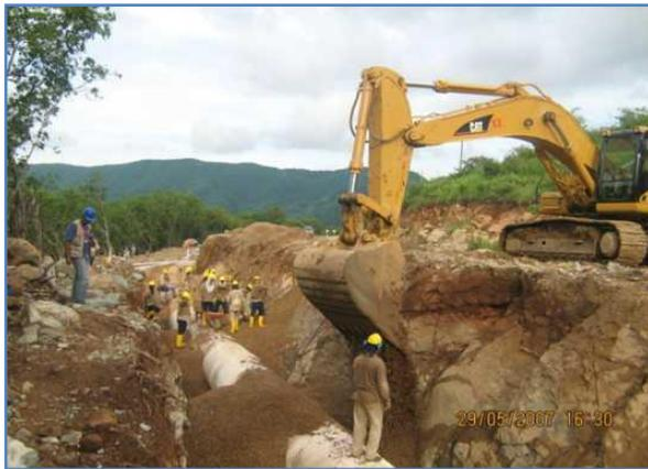
Foto No. 3 Colocación de relleno
