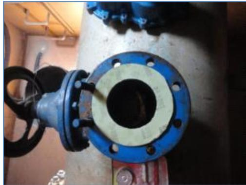
Foto No. 21 Reposición empaque en válvula ventosa K18+100
