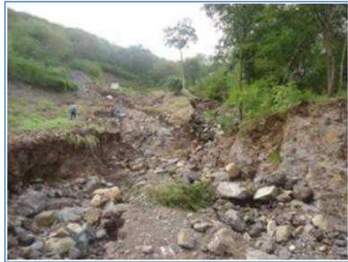
Foto No. 31 Erosión de terreno por presurización de túneles
