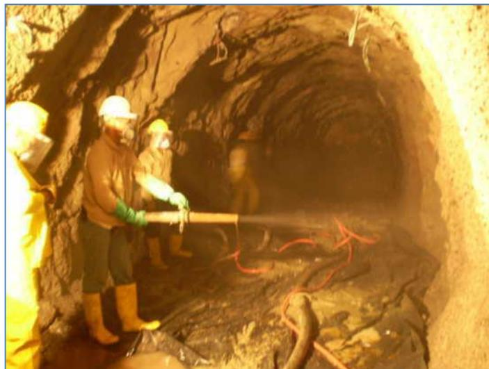
Foto No. 9 Concreto neumático, en paredes de túneles.
