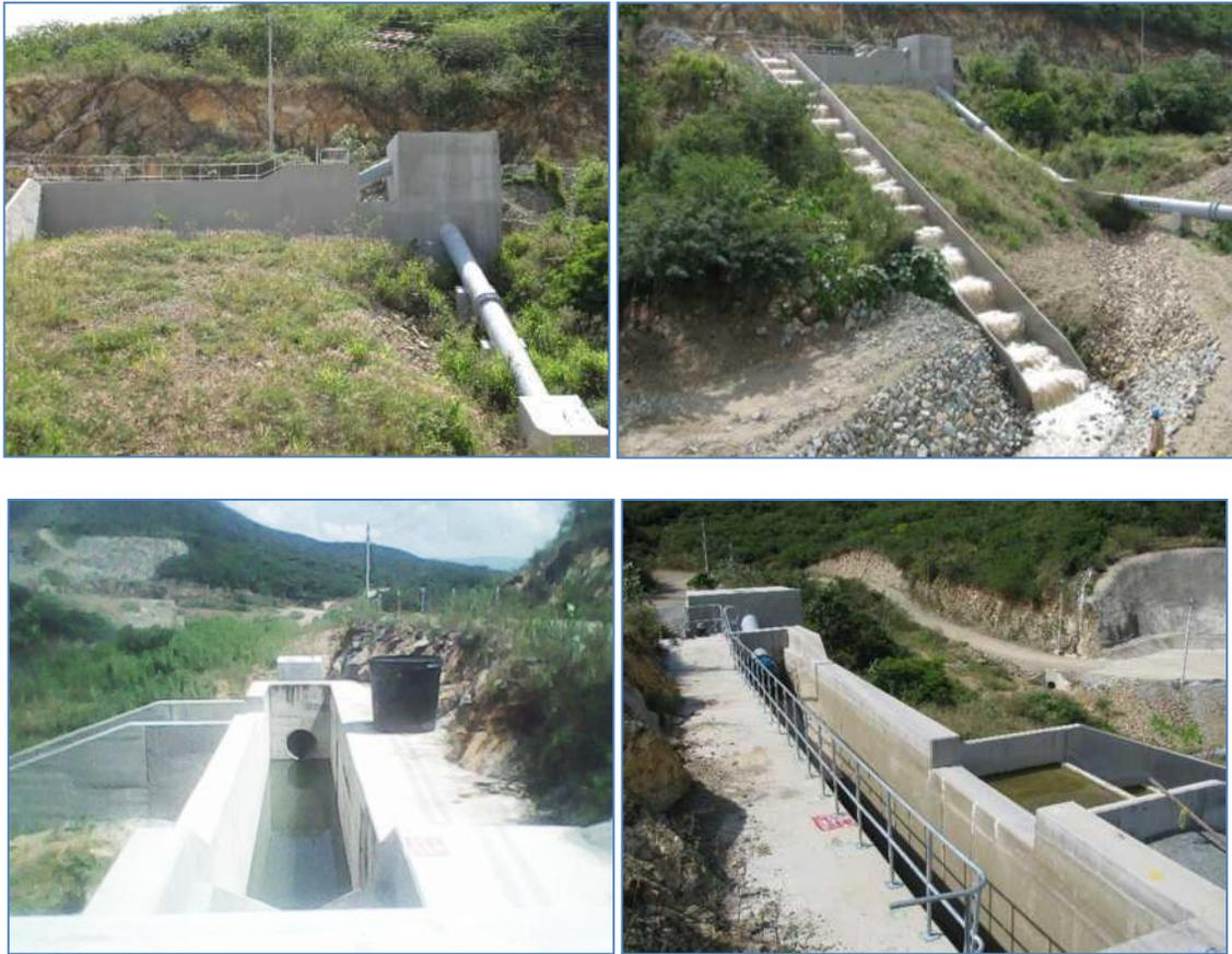
Foto No. 11 Tanque amortiguador de la Conducción San Juan, estructura de disipación
