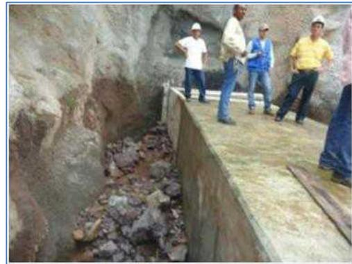
Foto No. 33 Daños en portal de salida del túnel 2
