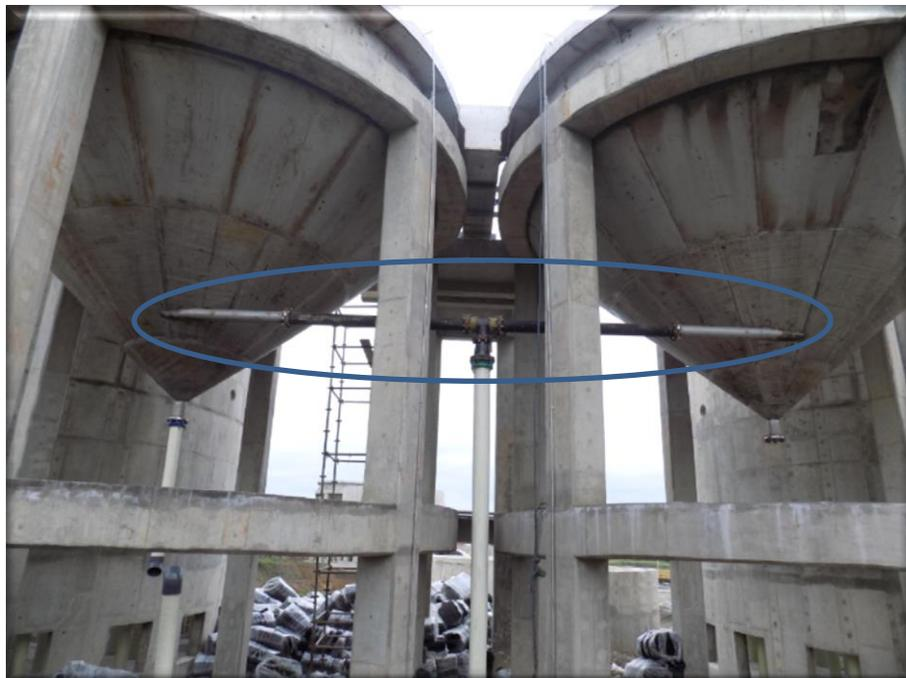
Foto 19. Tubería de llegada a los desarenadores aireados
