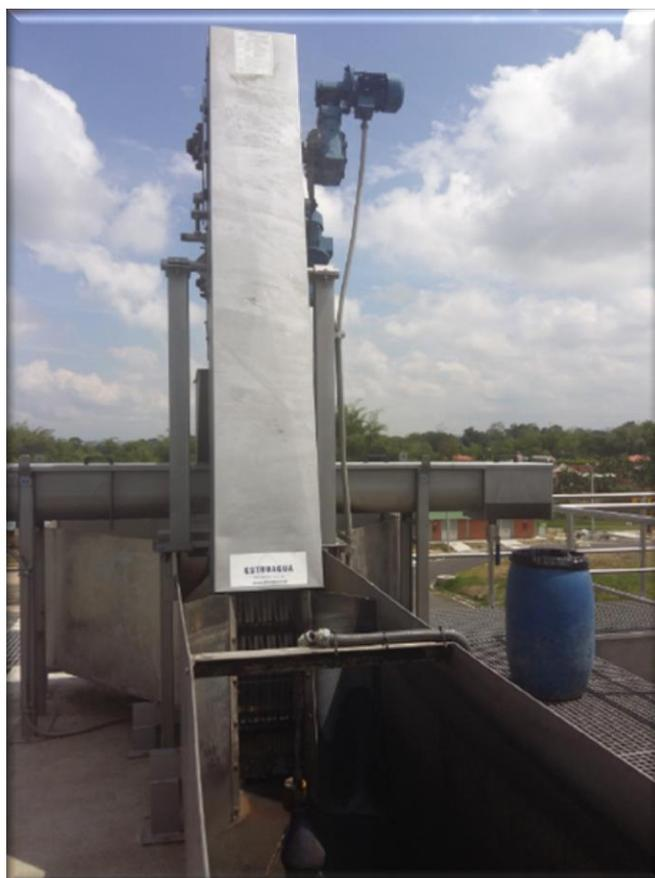
Foto 25. Tamiz filtrante autolimpiante y sinfín compactador helicoidal
