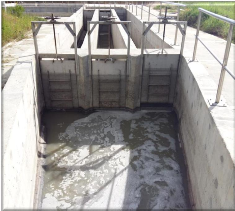
Foto 6. Entrada a desarenadores y compuertas rectangulares
