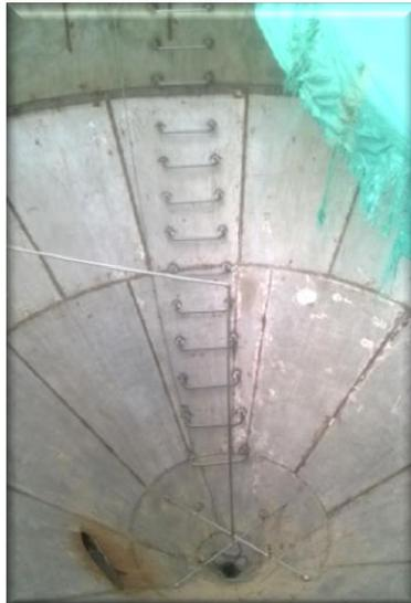
Foto 22. Desarenador aireado - Agitador de aire comprimido.
