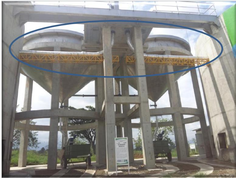
Foto 28. Tubería de 10" que conduce el agua a los filtros percoladores
