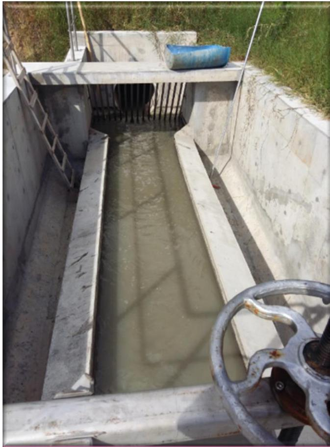
Foto 3. Canal vertedero y estructura de aliviadero
