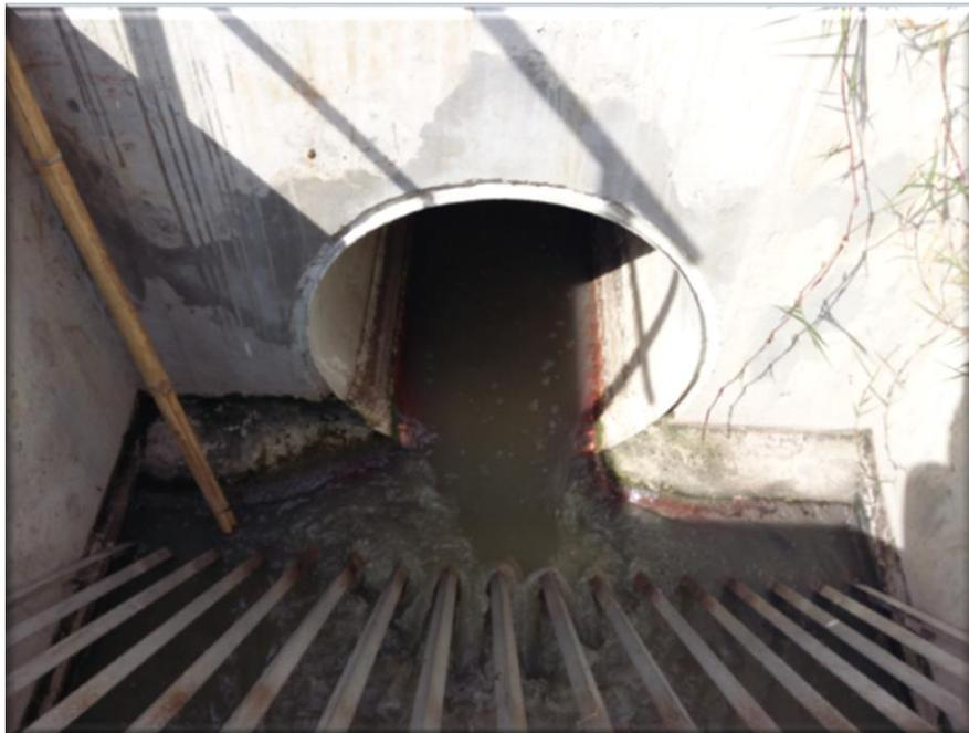
Foto1. Entrada del Colector a la estructura de llegada
