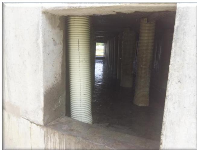
Foto 32. Columnas de soporte del lecho filtrante
