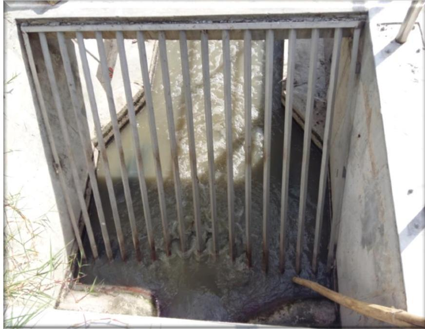
Foto 2. Rejilla gruesa en la estructura de llegada
