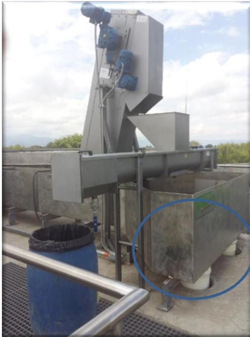
Foto 27. Salida del agua del vertedero Sutro a los filtros percoladores
