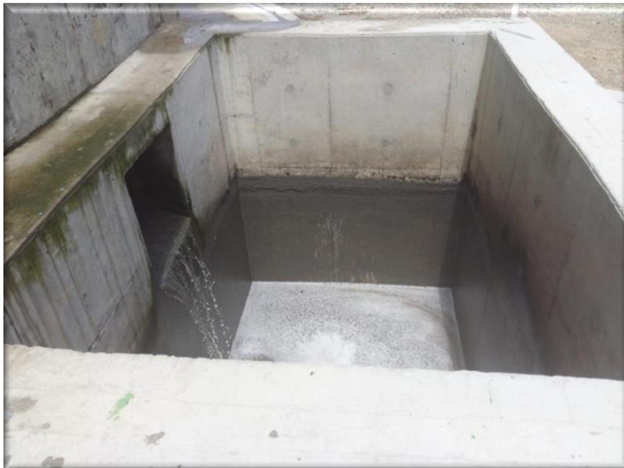
Foto 34. Cámara de salida del agua hacia el clarificador
