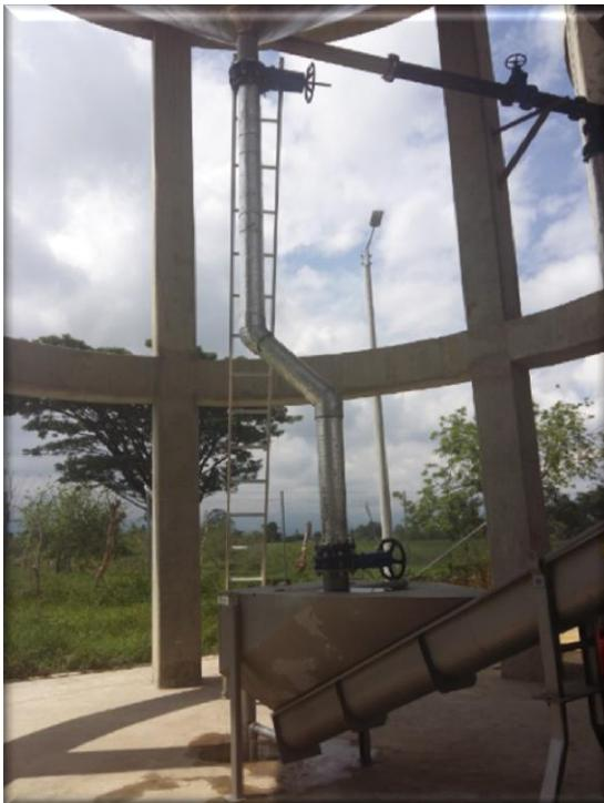
Foto 23. Salida hacia el clasificador de arenas
