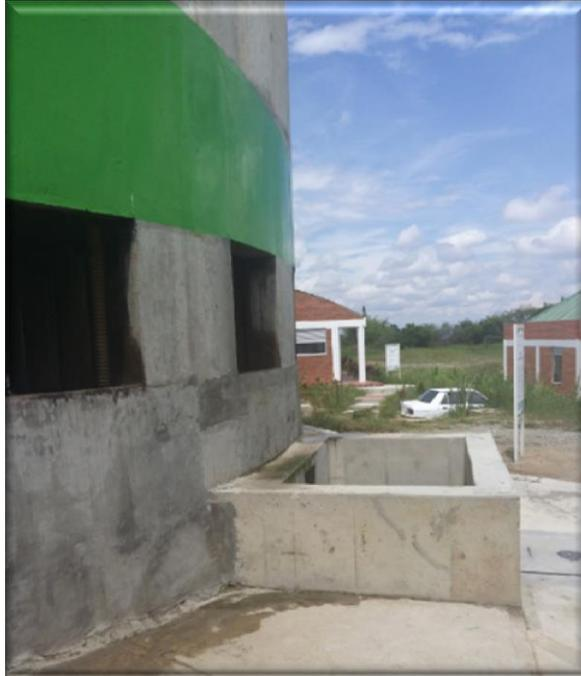
Foto 33. Cámara de salida hacia el clarificador.
