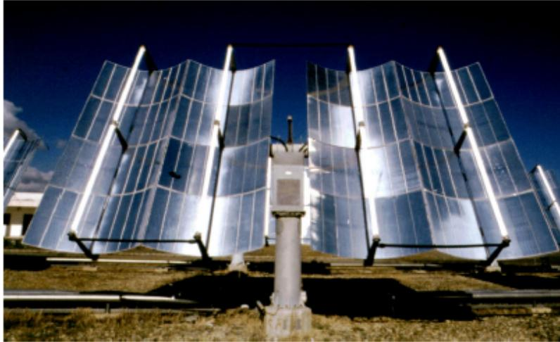
Figura 12. Colector cilindro parabólico con seguimiento en dos ejes instalado en la PSA, Plataforma Solar de Almería, España (BLANCO GALVEZ J., et al, 2001 b, p. 260)
