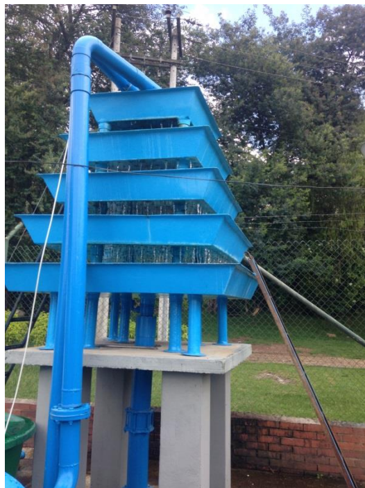
Ilustración 5 Bandeja de aireación. PTAP Sopó (Cundinamarca). Fuente: autor.
