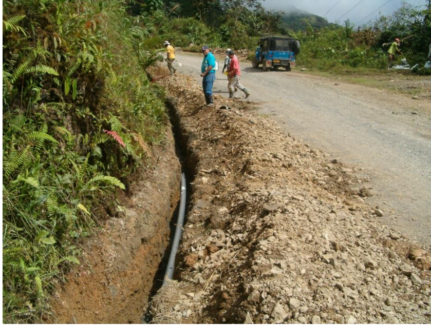
Ilustración 4 Tendido de una conducción, acueducto San José del Palmar (Chocó). Fuente: autor.
