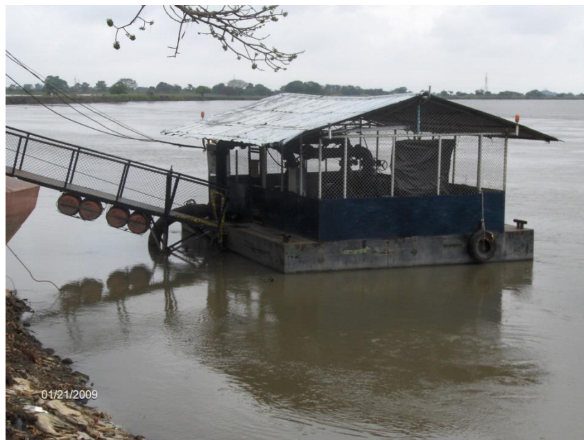
Ilustración 2 Bocatoma flotante, acueducto El Banco (Magdalena). Fuente: autor.
