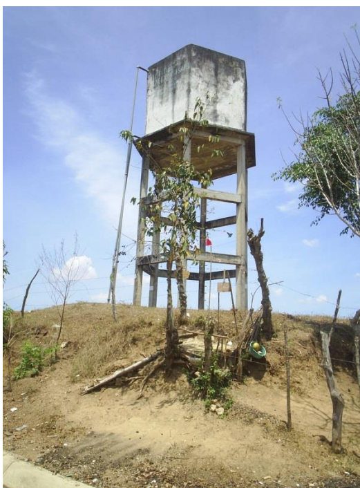
Ilustración 12 Tanque de almacenamiento elevado, acueducto de Sampués (Sucre). Fuente: autor
