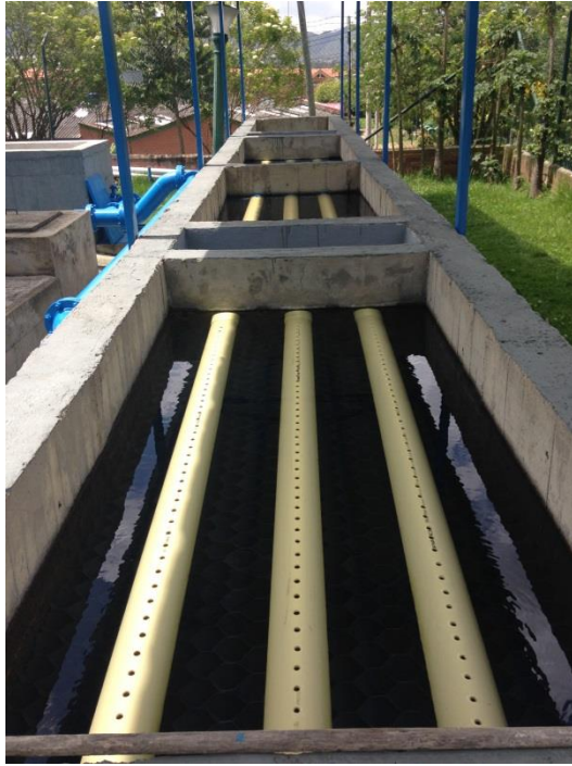
Ilustración 8 Sedimentación tasa acelerada. PTAP Sopó (Cundinamarca). Fuente: autor.
