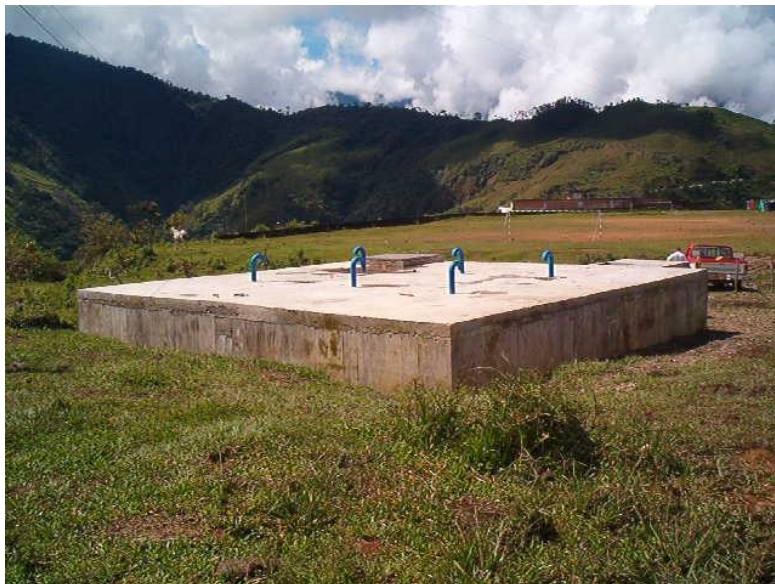
Ilustración 11 Tanque de almacenamiento semienterrado, acueducto San José del Palmar (Chocó). Fuente: autor.
