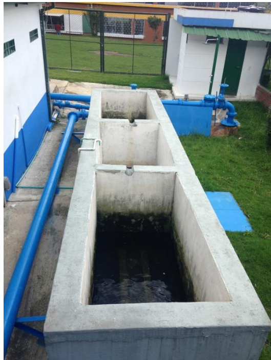
Ilustración 9 Filtración rápida. PTAP Sopó (Cundinamarca). Fuente: autor.
