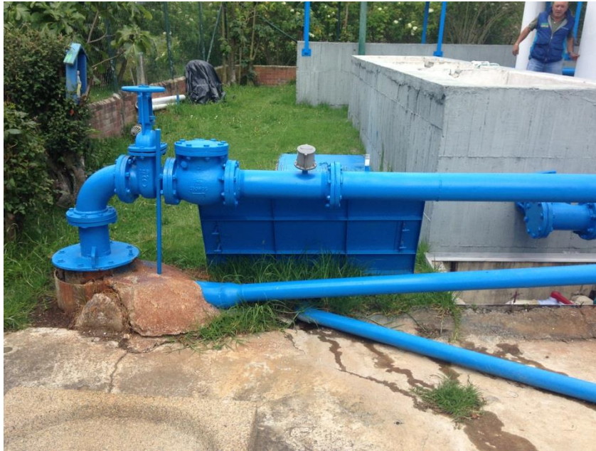
Ilustración 3 Estructura de captación profunda, acueducto de Sopó (Cundinamarca). Fuente: autor.
