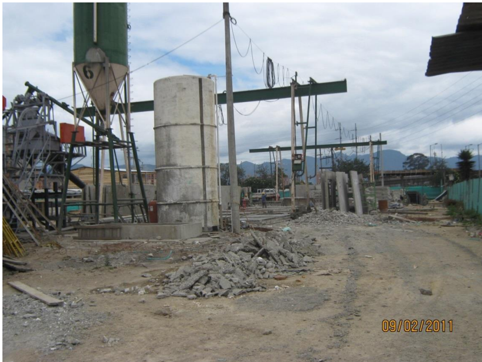
Fotografía No 1. Planta de producción de piezas prefabricadas. (Fuente: Roque Armenta, IC constructora SAS).
