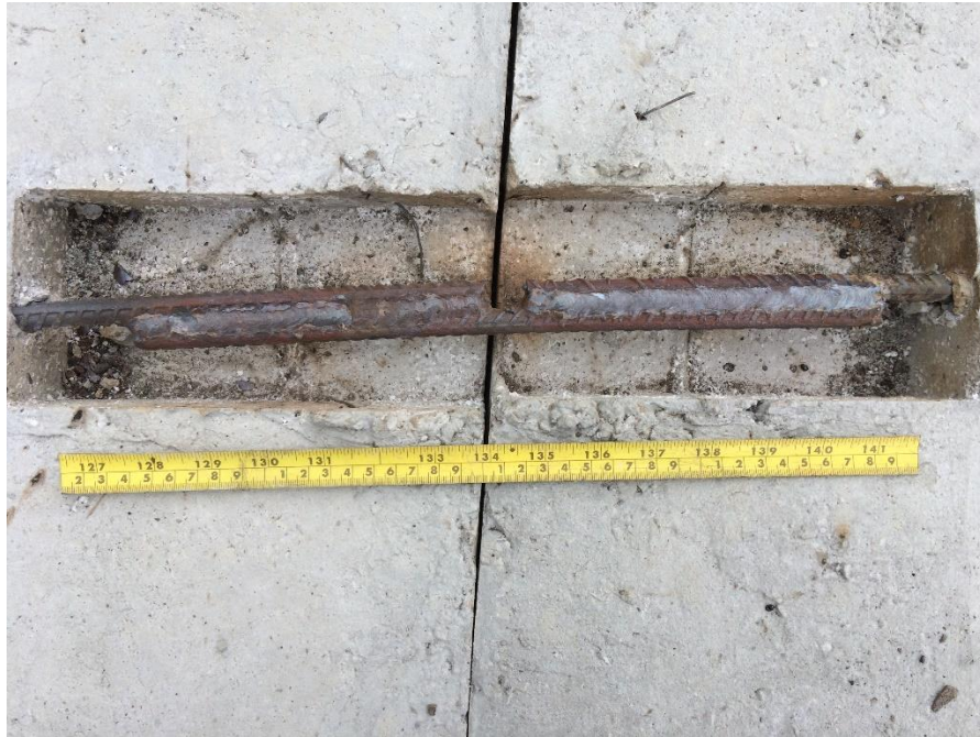
Fotografía No. 4. Conexión con refuerzo corrugado traslapado y soldado.
