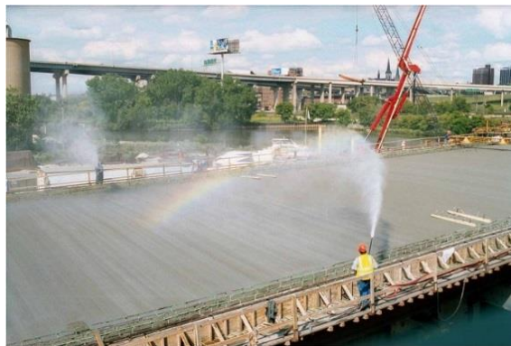
Ilustración 1 curado del concreto
