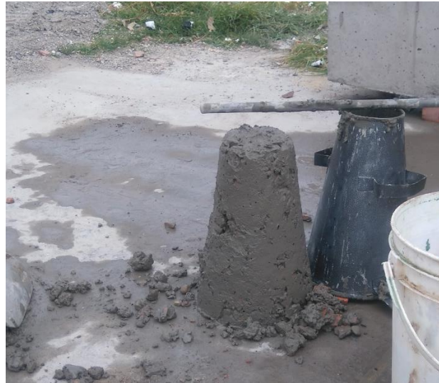
Ilustración 5-6 Ensayo de asentamiento
