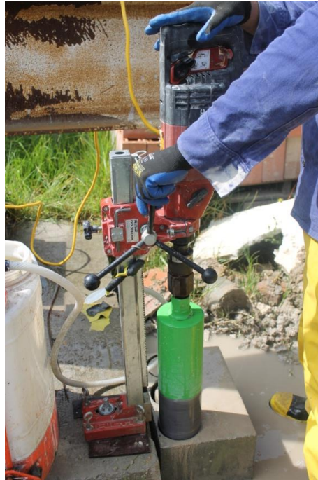
Ilustración 4-4 Extracción de núcleos de concreto
