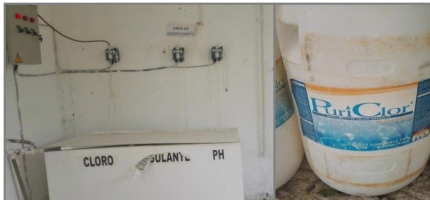
Fotografía 21 Dosificadora de Cloro
