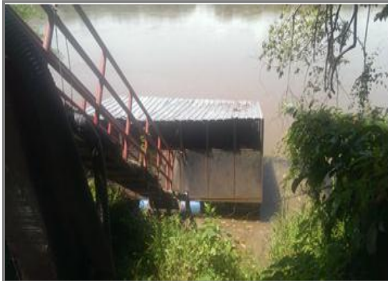
Fotografía 6 Bocatoma Río Magdalena
