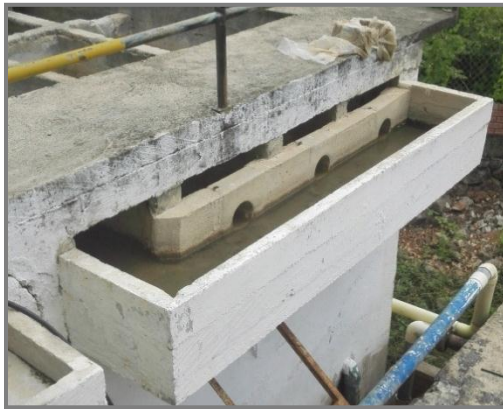
Fotografía 20 Salidas Unidades de Filtración
