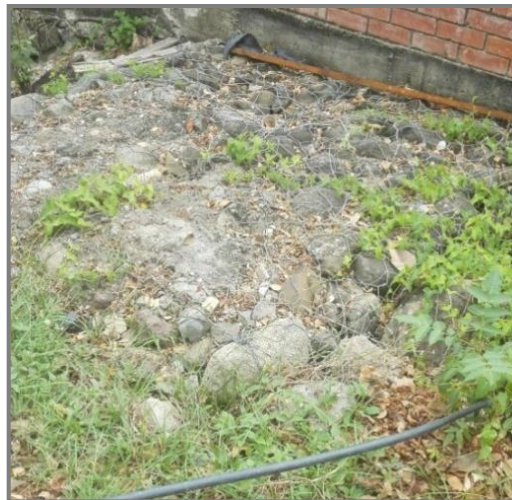
Fotografía 11 Gaviones para estabilidad del Talud
