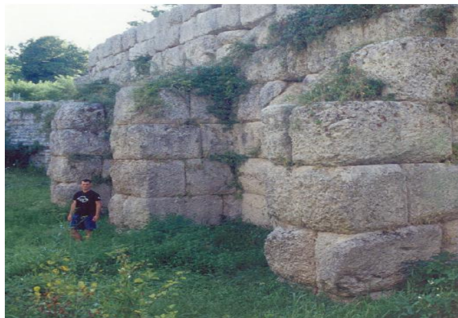
Figura 4. Muro de contención con contrafuertes - romano en la vía Flaminia (Italia).
