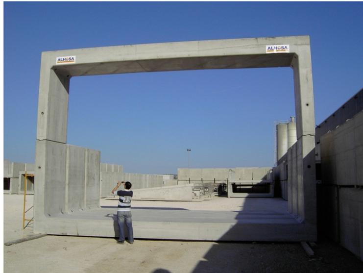
Figura 30: Marco en concreto prefabricado
