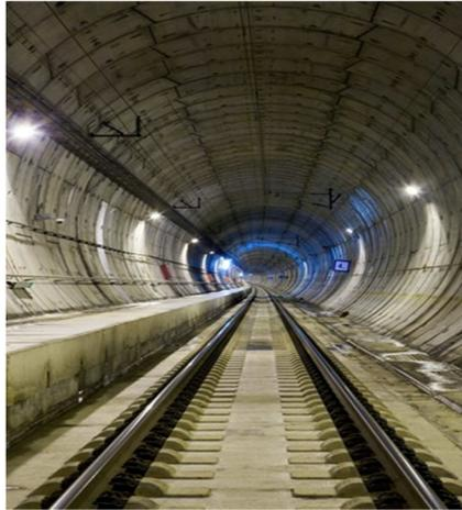
Figura 28: Túnel revestido con dovelas prefabricadas
