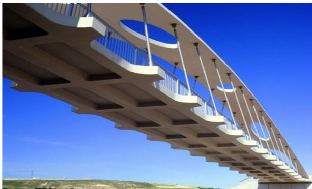
**Figura 24: Puente colgante en arco, con pasarela y arco en concreto prefabricado**
