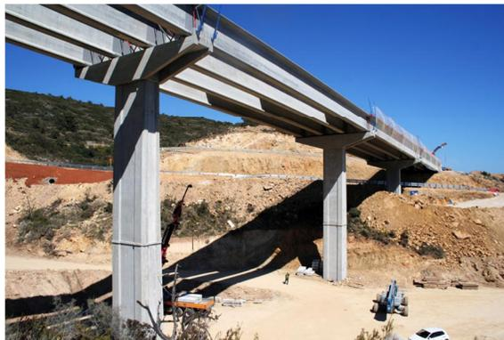
Figura 29: Puente con elementos prefabricados como pilas, pilas y vigas
