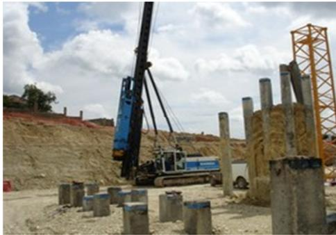
**Figura 7. Hincado de pilotes prefabricados en concreto.**
