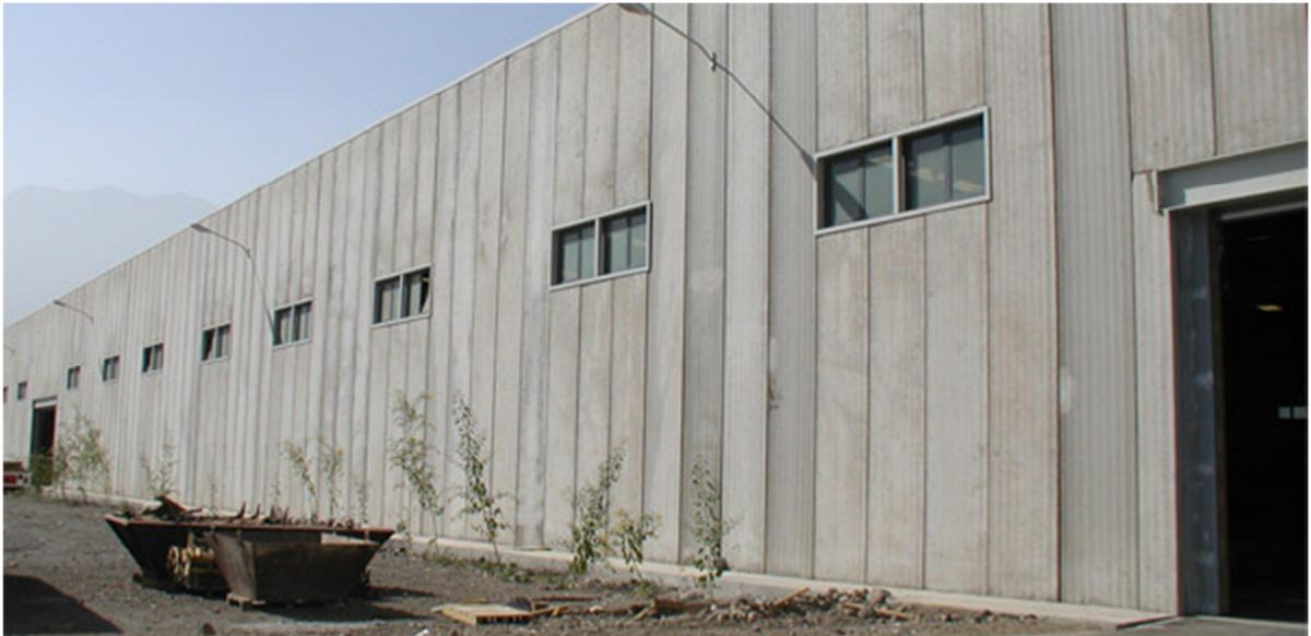
Figura 5. Muros en losa alveolar, con alveolos alineados en forma vertical.
