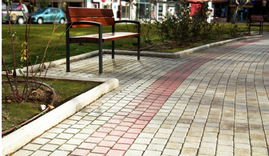
**Figura 23: Pavimento adoquinado confinado por bordillos**
