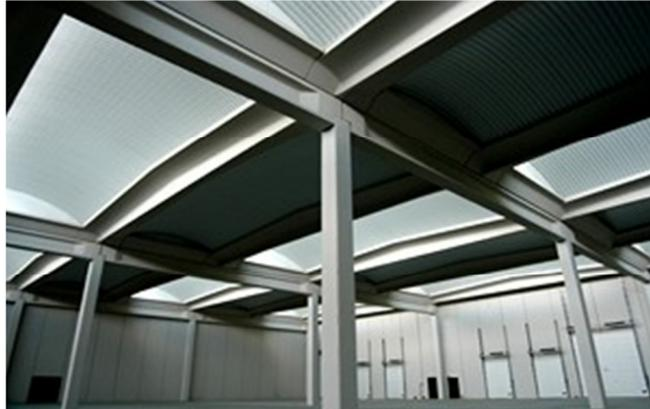
**Figura 11. Nave industrial, donde se muestran elementos lineales prefabricados en concreto, como vigas y columnas.**
