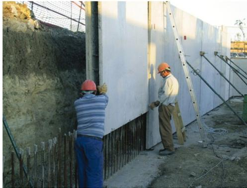
Figura 6. Muro doble en concreto prefabricado.
