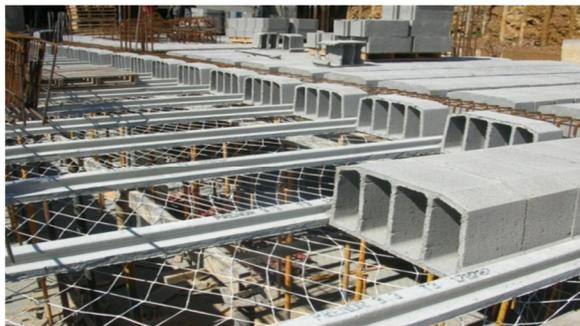
Figura 17. Losa aligerada de vigueta y casetón
