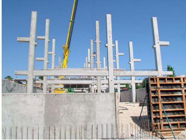
Figura 13. Columnas de sección rectangular en concreto prefabricado.
