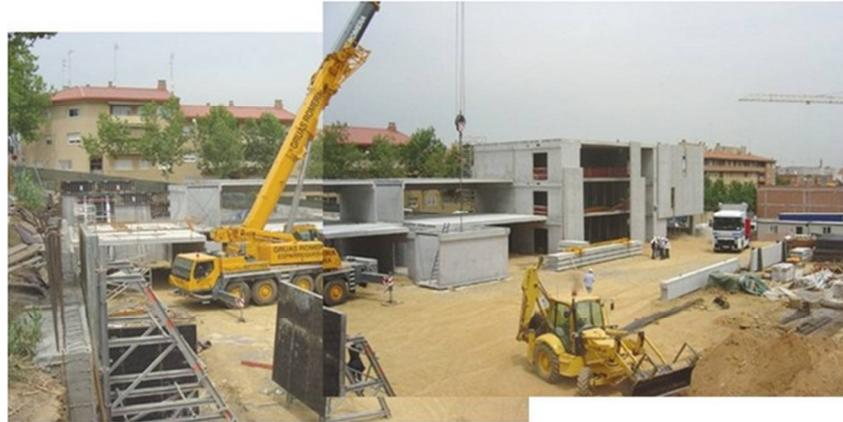
**Figura 33: Edificación modular compuesta por elementos bidimensionales y lineales**
