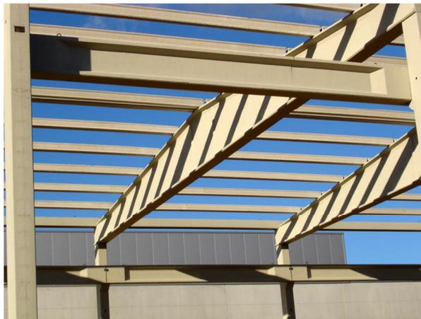
**Figura 12: Vigas prefabricadas en concreto, de secciones variables.**
