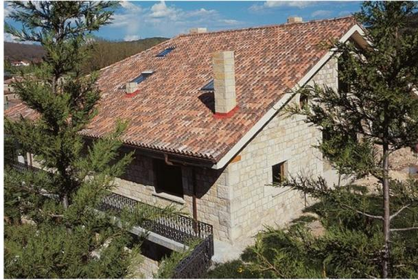
Figura 9. Cubierta en Tejas de concreto prefabricado.
