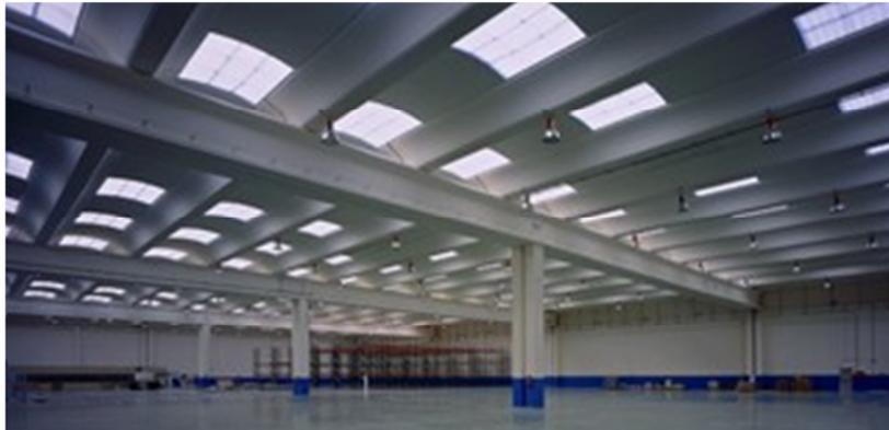
Figura 10. Vigas prefabricadas en concreto, como soporte de cubiertas.
