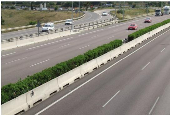
Figura 26: Barreras de contención en concreto prefabricado como separador vial
