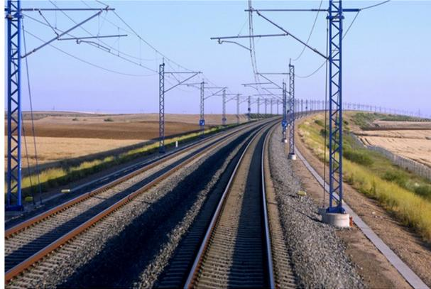
Figura 25: Vía férrea, con traviesas en concreto prefabricado
