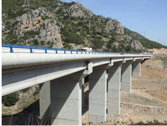
**Figura 27: Pretilos prefabricados como elementos de contención en puentes**
