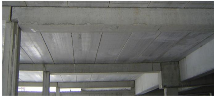
Figura 15. Losa Alveolar y vigas prefabricadas en concreto.
