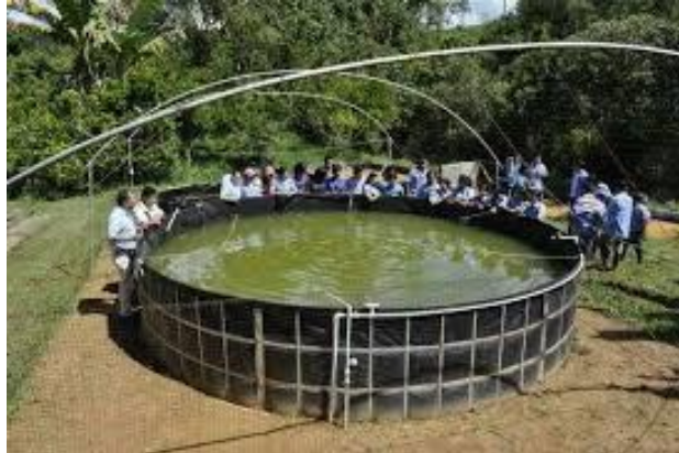
Figura 8. Estanque con geomembrana
