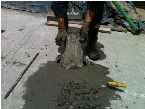
Fotografía 23. Toma del asentamiento de la mezcla
