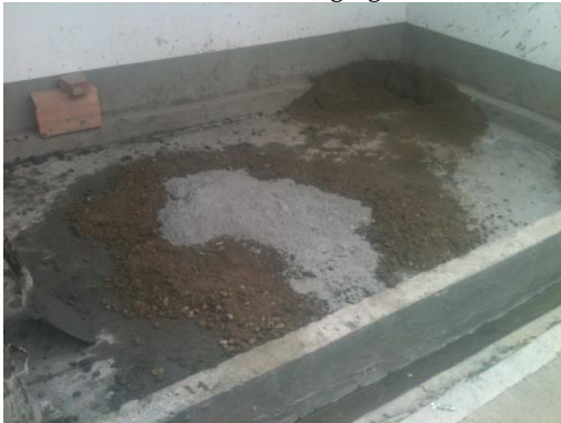
Fotografía 16. Elaboración de las mezclas
