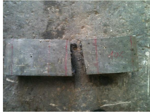
Nota: se observa que la línea de falla ocurrió en el tercio medio de la vigueta
