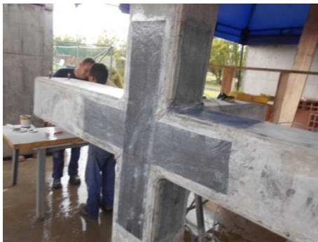
3- Colocación de tejido horizontal y vertical
