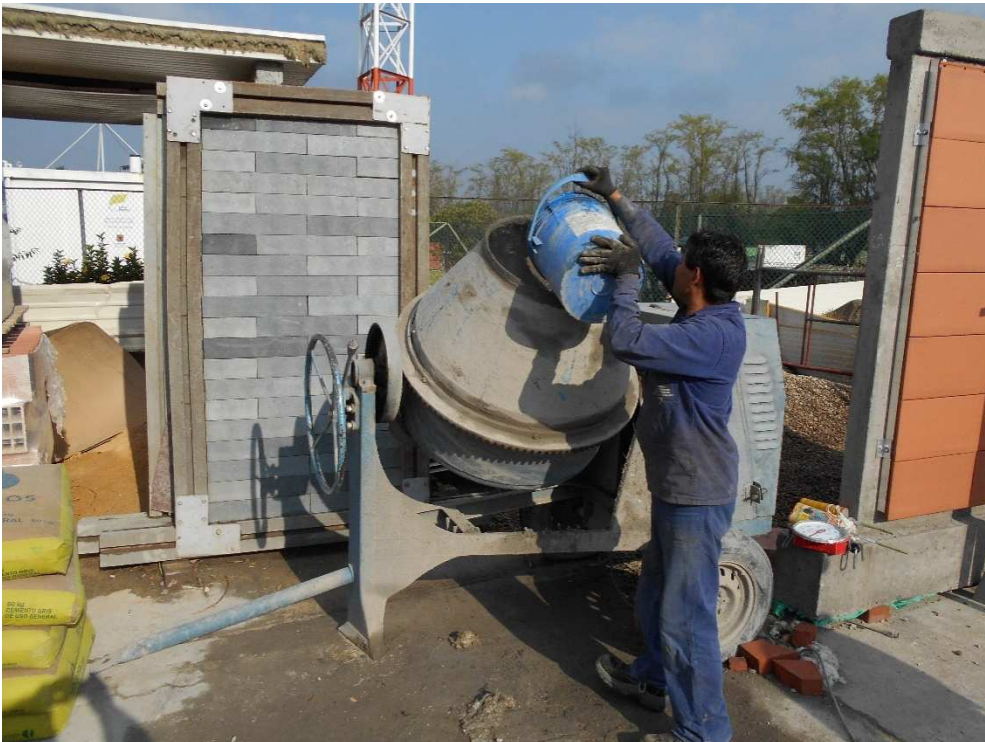
Figura 4-12. Preparación de la mezcla.
