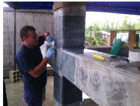
4- Confinamiento de vigas y columnas y curado final con adhesivo epoxico
