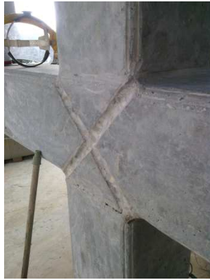
1- Preparación de la superficie
