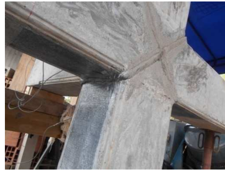
2- Colocación de las eses y los cordones
