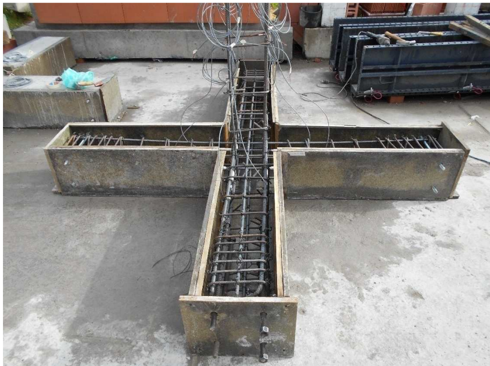
Figura 4-10. Canasta de refuerzo.
