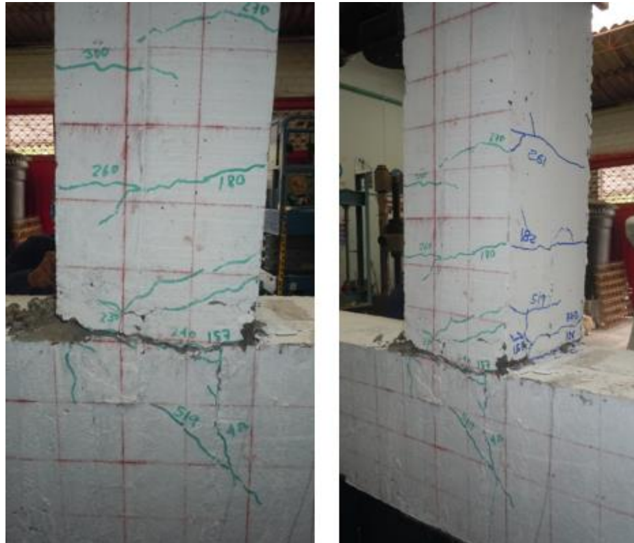
Fotografía 3- 12: Condición del prototipo AEZC-6, después del ensayo
