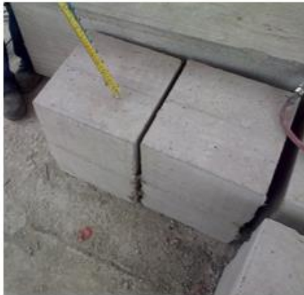
Fotografía 2- 6: Localización y perforación en macizos para anclaje
