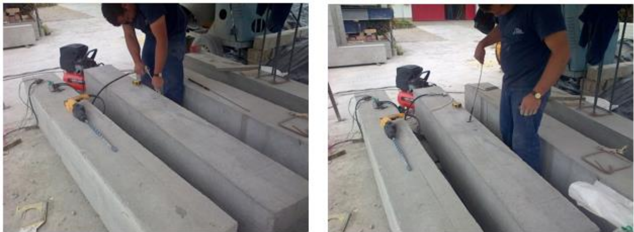
Fotografía 2- 12: Armado del refuerzo de vigas ancladas con epóxico
