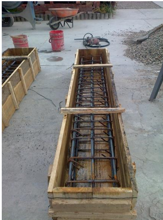
Fotografía 2- 2: Colocación del refuerzo dentro de la formaleta
