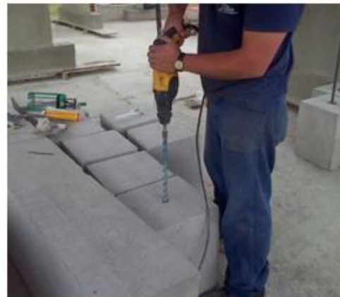
Fotografía 2- 6: Localización y perforación en macizos para anclaje
