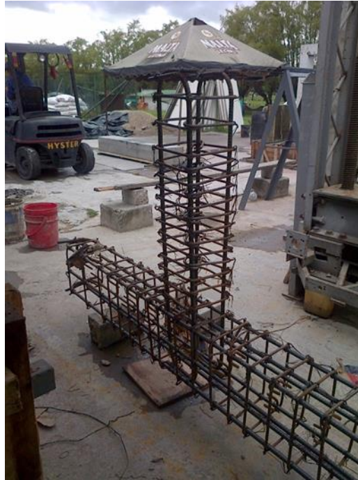
Fotografía 2- 15: Disposición del refuerzo unión monolítica
