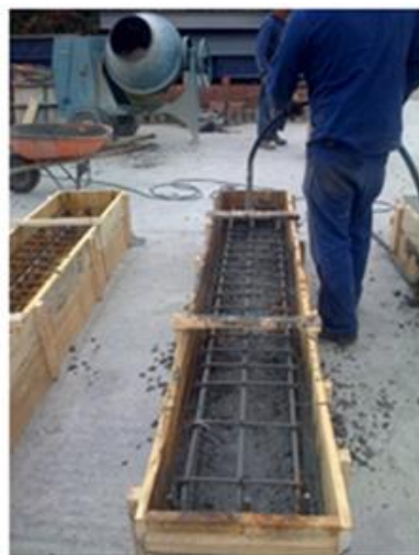
Fotografía 2- 4: Vibrado del concreto.
