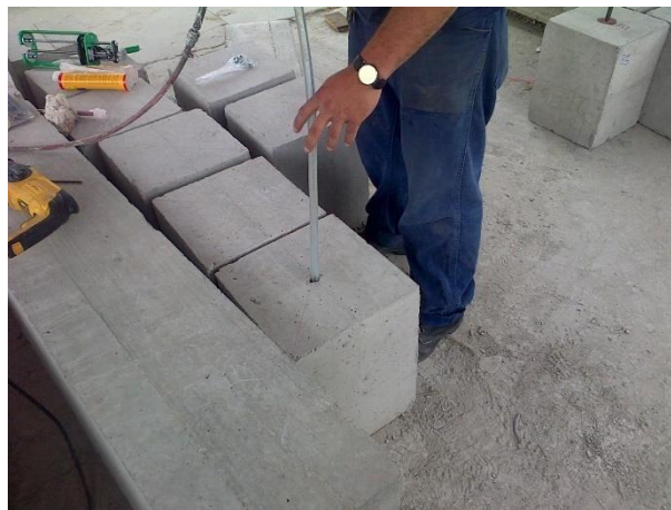
Fotografía 2- 7: Limpieza con aire a presión de orificios
