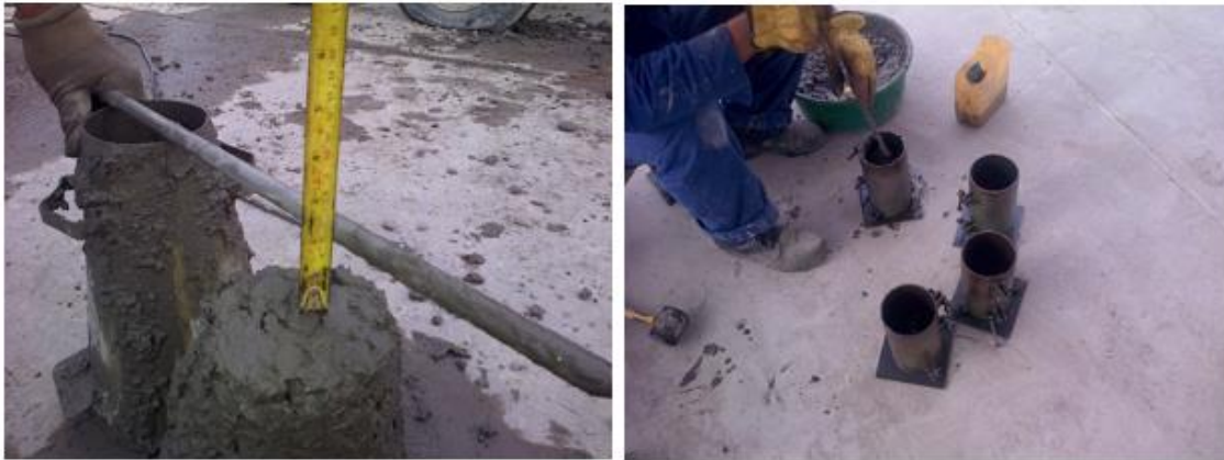
(a) Ensayo de asentamiento
