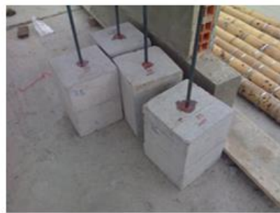
(b) Barras ancladas en Macizos con adhesivo 2
