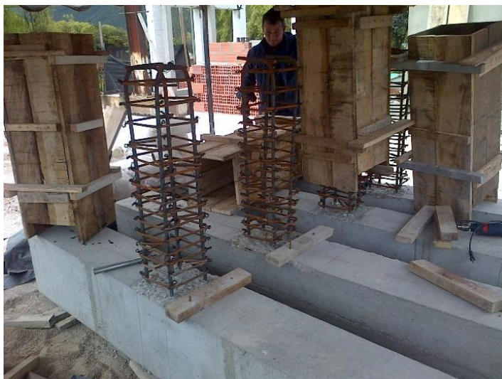
Fotografía 2- 12: Armado del refuerzo de vigas ancladas con epóxico
