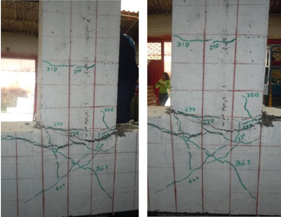
Fotografía 3- 6: Condición del prototipo AEZC-3, después del ensayo
